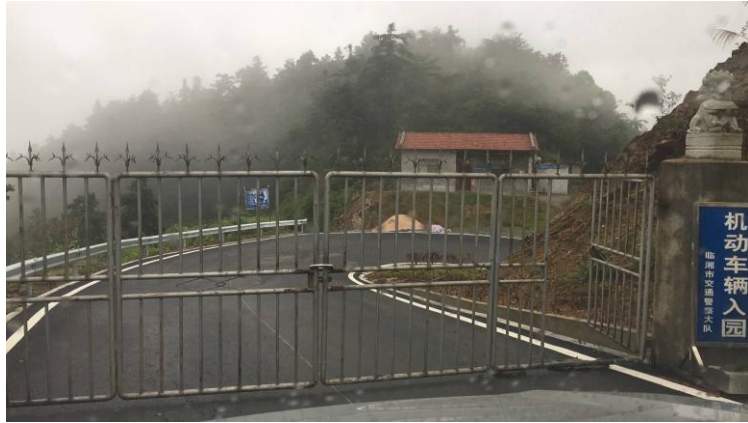
林场护林房（进场道路附近）
