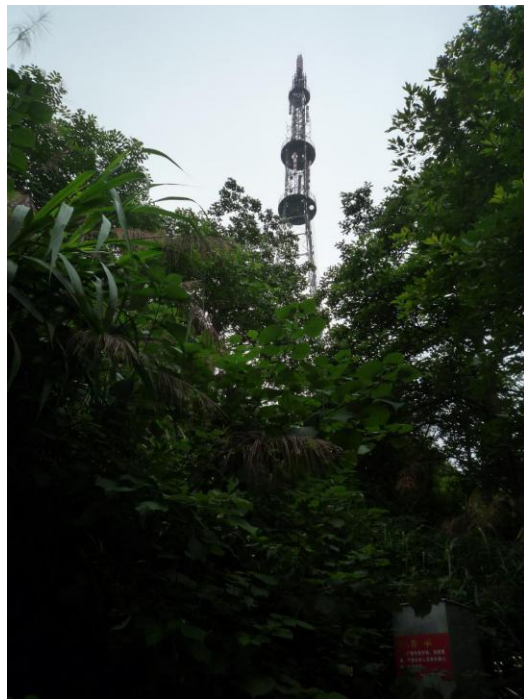
临湘市电视转播塔（25#风机东面 350m）
