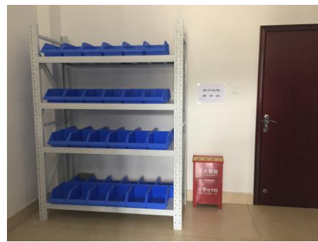
废旧铅酸蓄电池临时储存间配备防渗电池底座、电池组货架及消防设施
