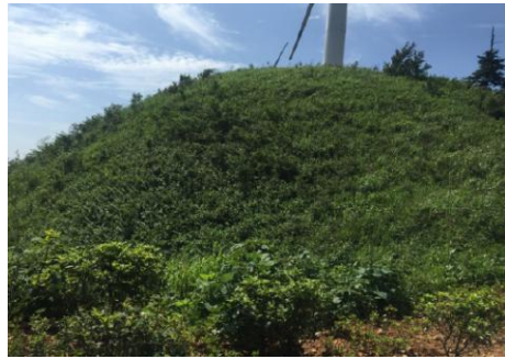
风机平台表土回填绿化
