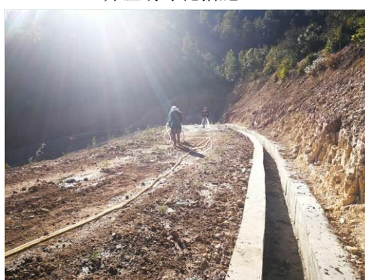
2#弃渣场排水及绿化措施
