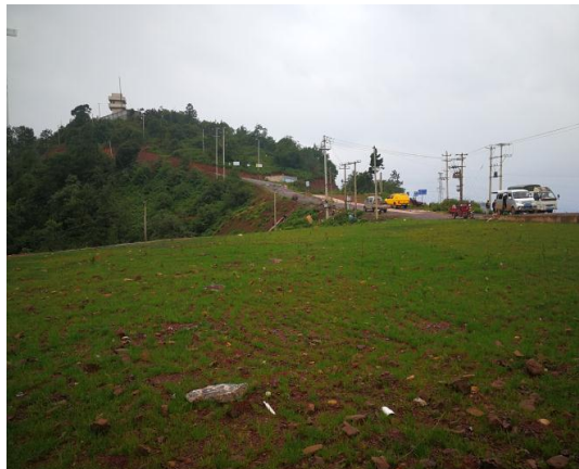
施工场地恢复情况（二）
