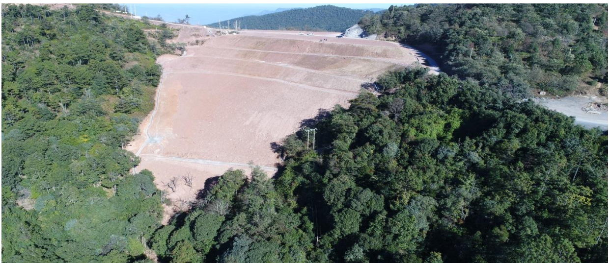
3#弃渣场建设情况
