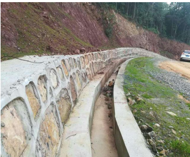
道路边坡挡墙和排水沟
