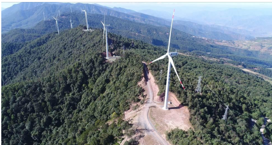
风机机组区概况
