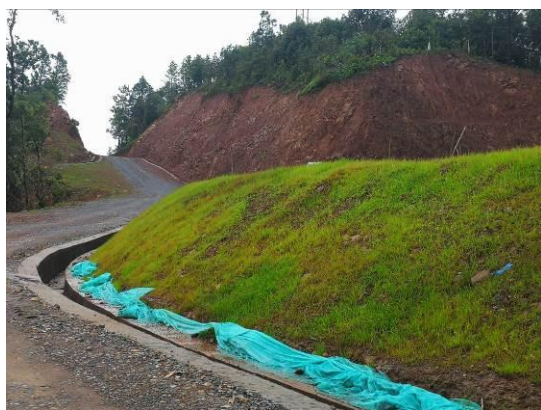
场内道路概况（一）
