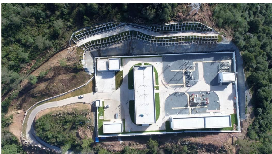
升压站区建设情况
