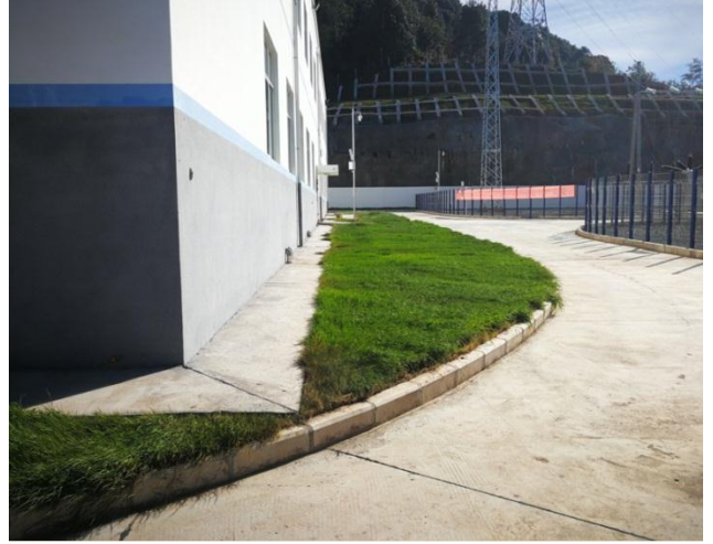
升压站内绿化
