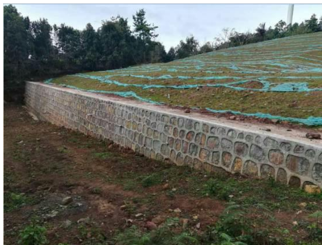
1号弃渣场拦渣坝
