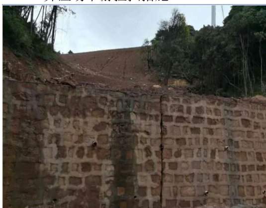
3#弃渣场下游拦挡措施
