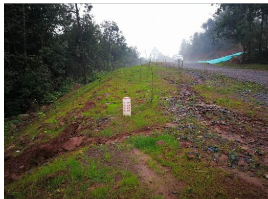
集电线路完成植被恢复
