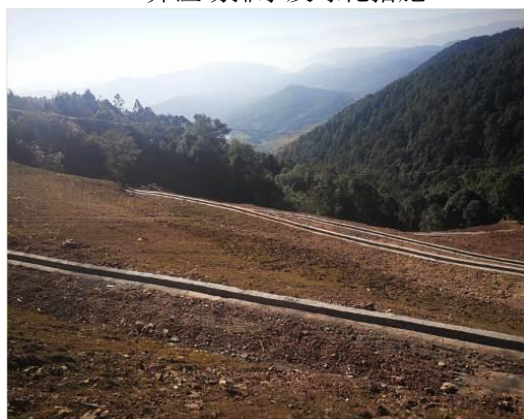
3#弃渣场马道及绿化措施
