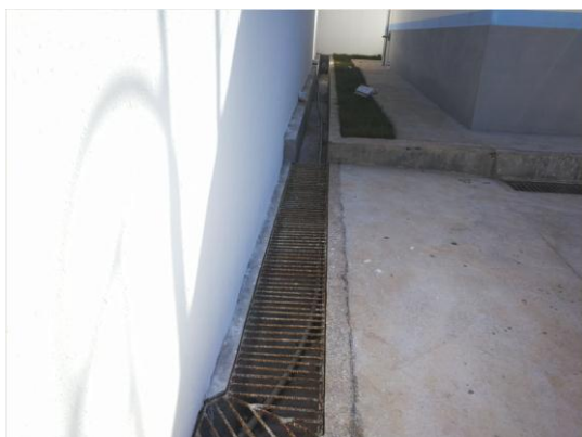
升压站雨水篦子排水沟
