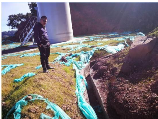
风机机组区内排水沟
