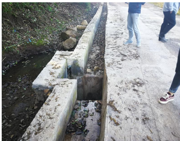
道路排水及沉砂池
