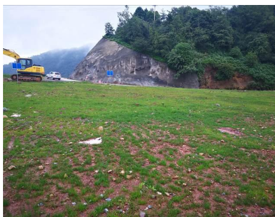
施工场地恢复情况（一）
