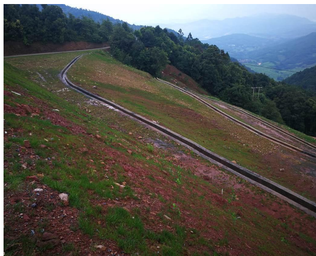
3号弃渣场马道排水沟
