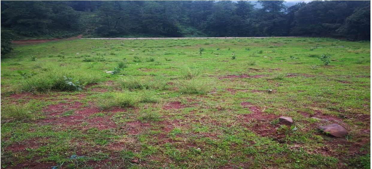
1#弃渣场建设情况
