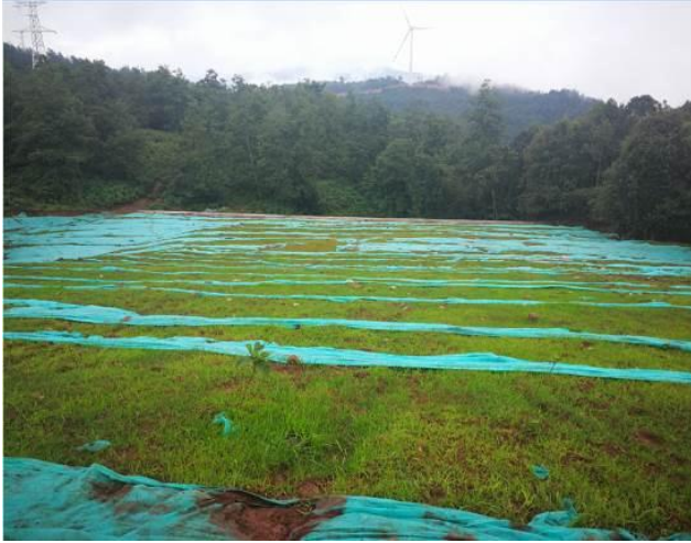
1号1弃渣场植被恢复情况
