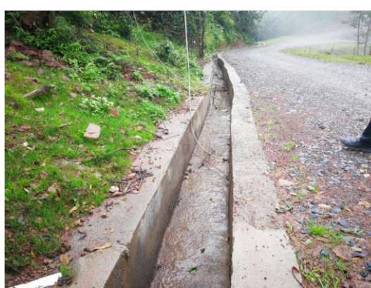
场内道路概况（二）
