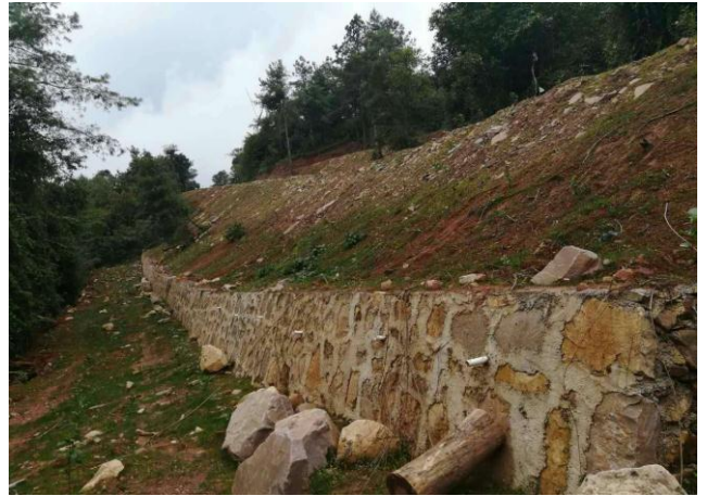
道路下边坡挡墙
