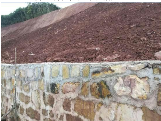
2#弃渣场下游拦挡措施
