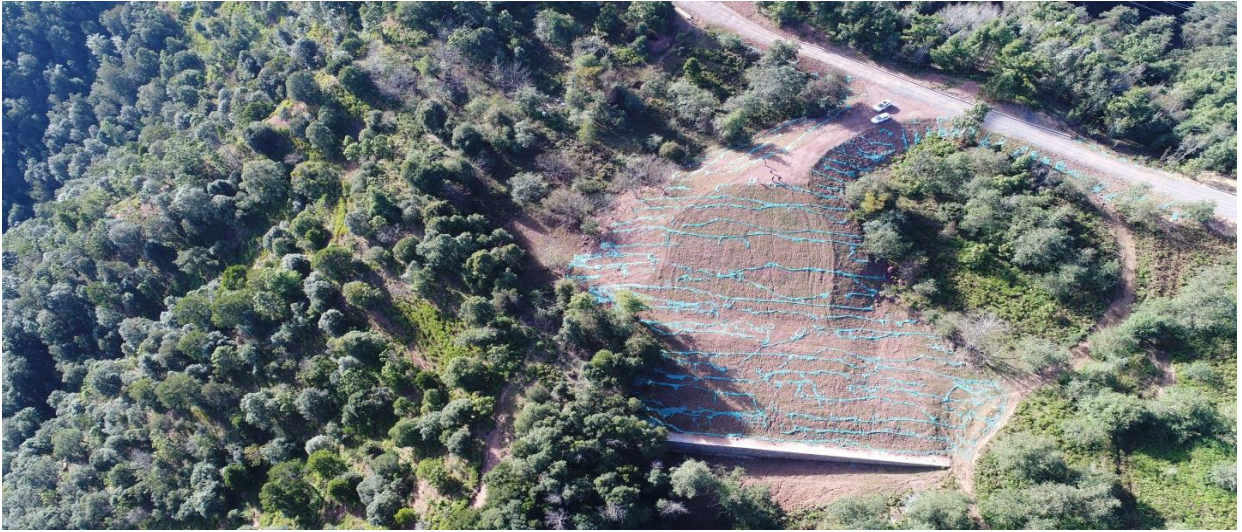
1#弃渣场建设情况
