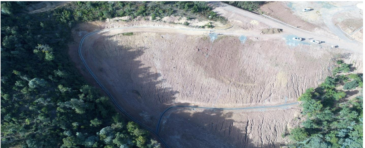
2#弃渣场建设情况
