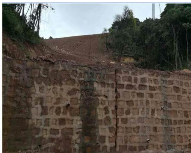
3号弃渣场拦渣坝
