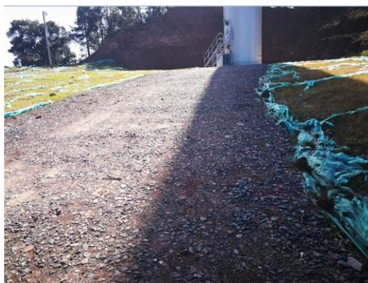
风机机组区内碎石铺垫和无纺布覆盖
