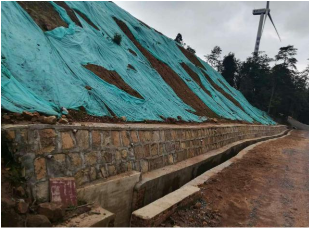
道路边坡挡墙和排水沟
