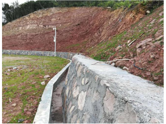
风机机组挡墙和排水
