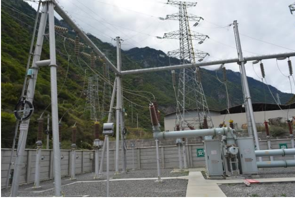
沙溪变电站间隔扩建
