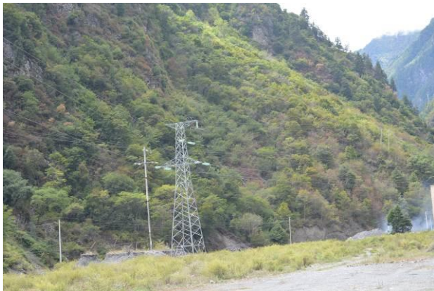
梭沙线 5#塔基周边绿化
