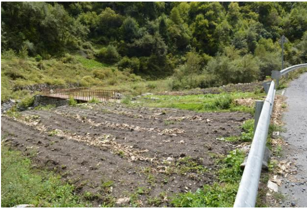
塔基施工临时占地
