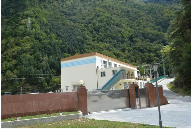
线路起点梭罗沟二级电站
