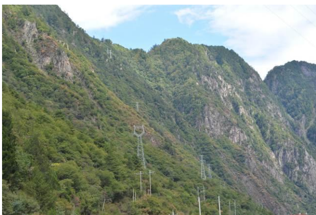
梭沙线 7#~13#塔基现状
