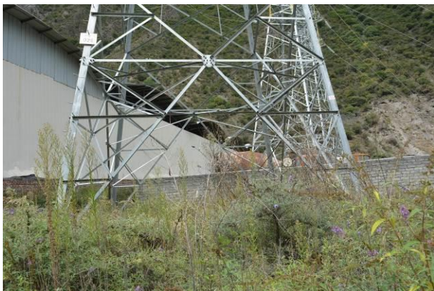
梭沙线 26#塔基周边绿化
