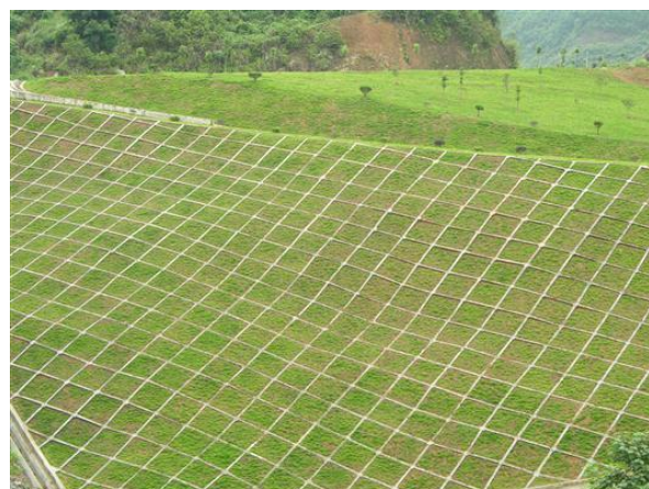
公路外侧浆砌石网格护坡及排水沟
