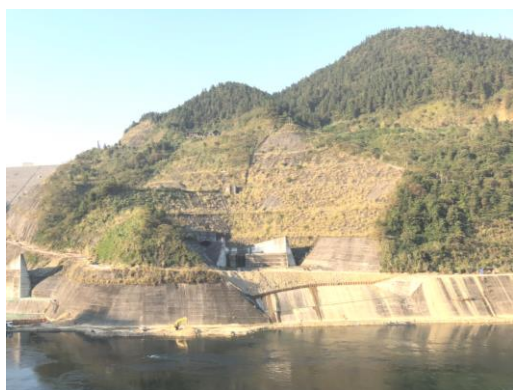
大坝枢纽工程区护坡
