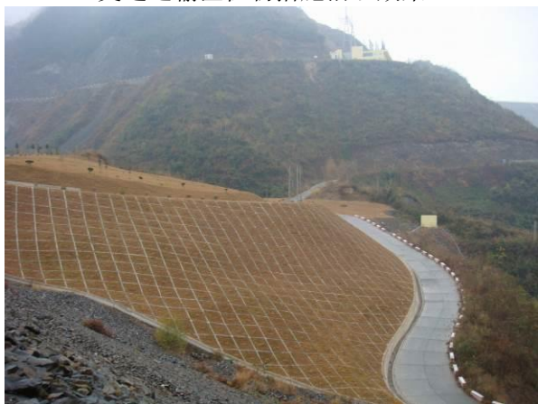
进场公路边坡
