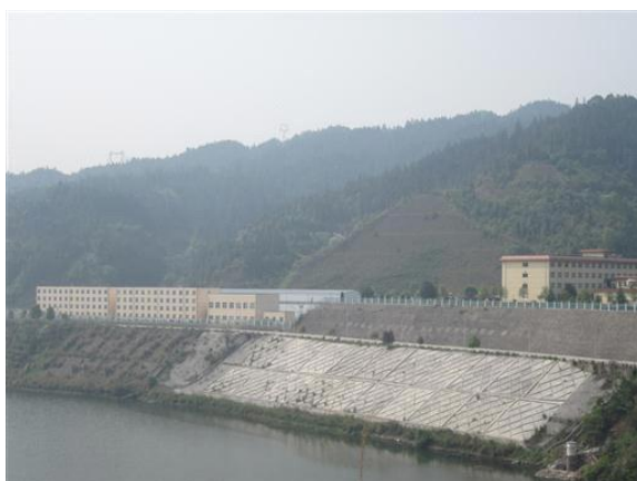
施工营地及办公营地区护坡及挡土墙
