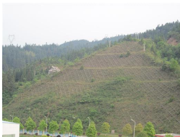
施工营地及办公营地区护坡
