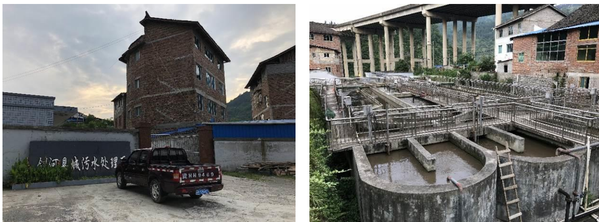
图 4.5-1 剑河县污水处理厂现场面貌
