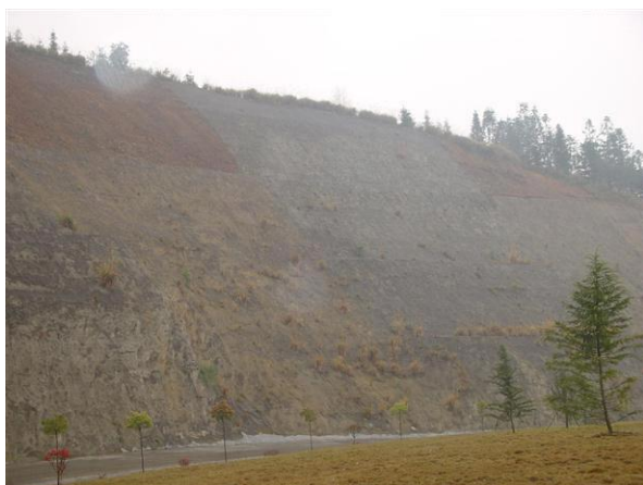
交通运输系统区护坡及挡土墙
