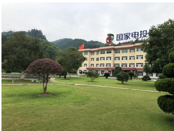
施工营地及办公营地区植物措施治理效果
