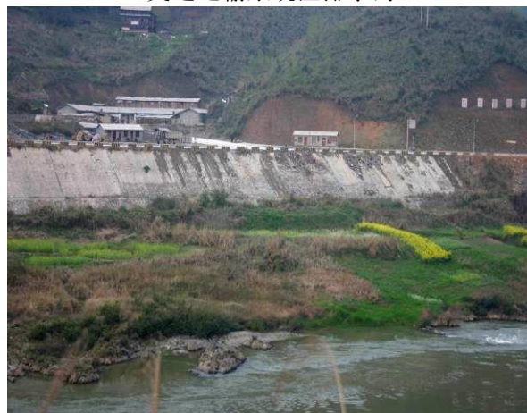
右岸上坝公路沿线浆砌石挡墙
