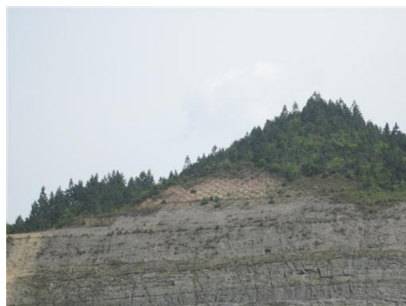
八洋河料场区顶部的浆砌石网格护坡
