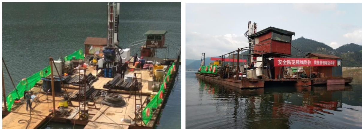
图 4.2-5 低温水治理隔水幕墙施工平台
