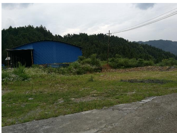
归浪溪渣场植被恢复
