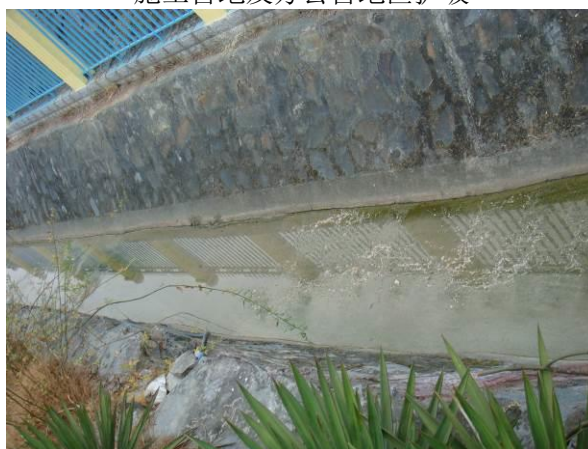
施工区排洪沟
