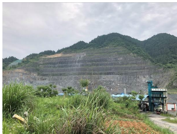
八洋河料场、渣场植被恢复
