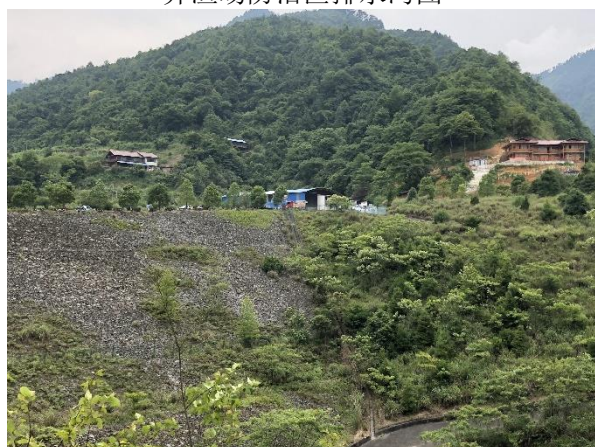
南斗溪 II 号渣场护坡、排水沟
