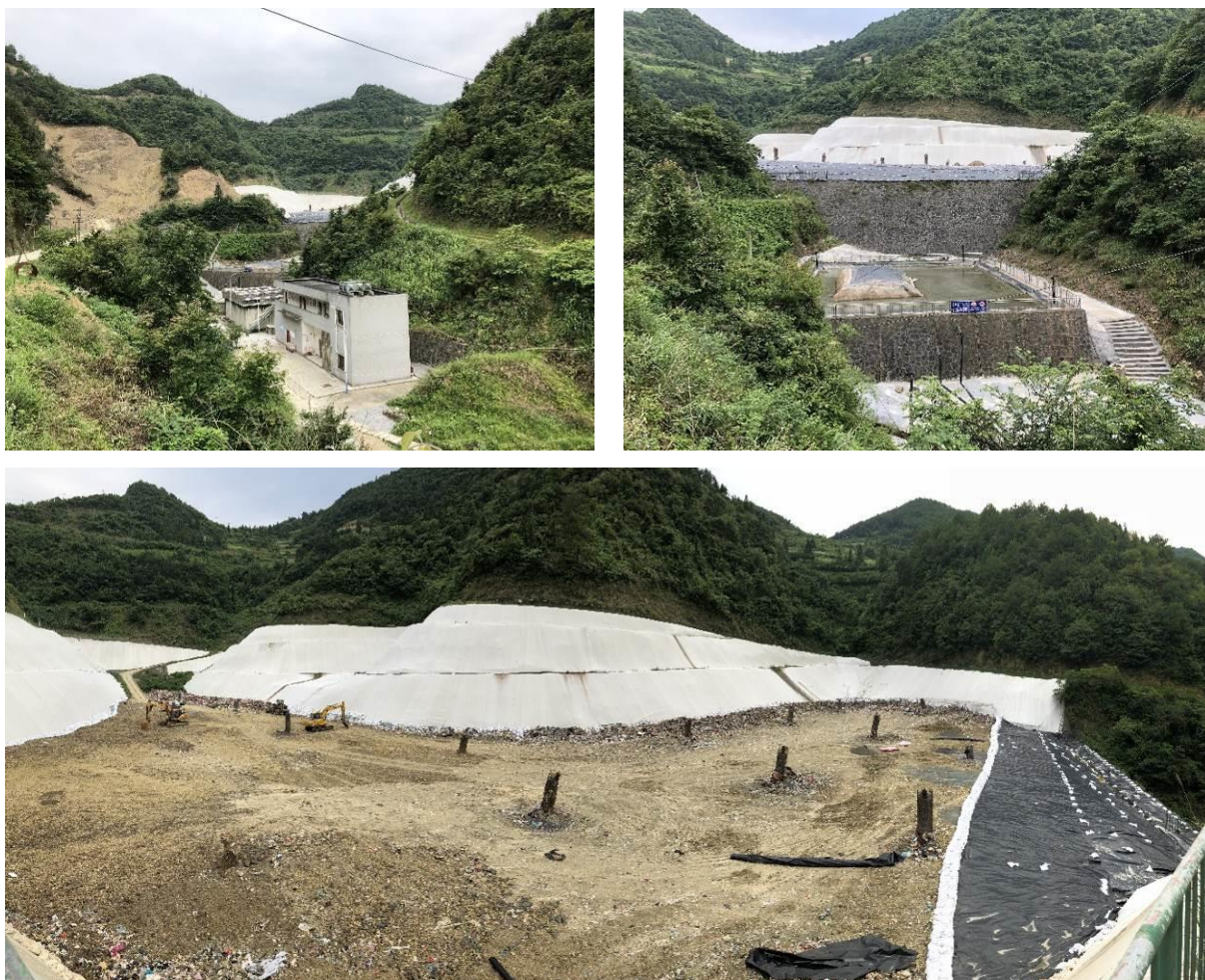
图 4.5-3 剑河县生活垃圾填埋场现场面貌
