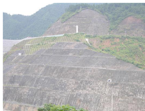
大坝枢纽工程区护坡及截水沟
