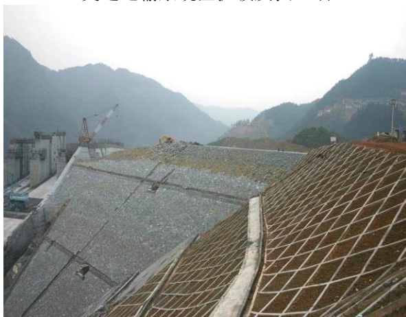
右岸上坝公路沿线喷护
