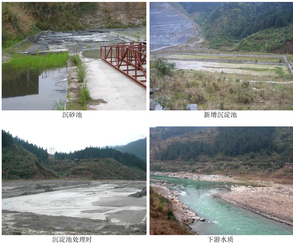
图 4.3-2 砂石料系统沉淀池
