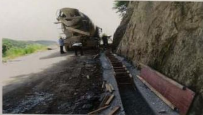
道路排水沟施工
