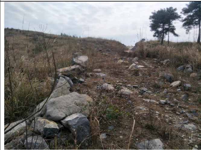
弃渣场施工前
