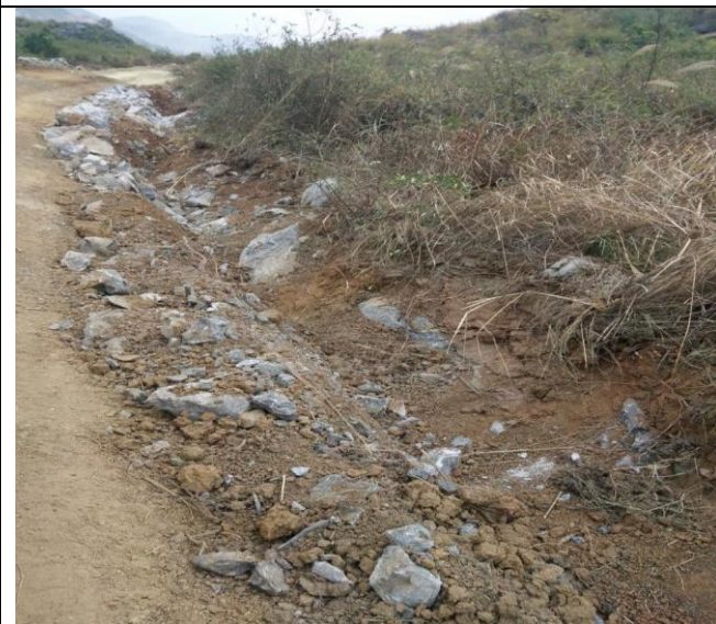
生态沟施工前
