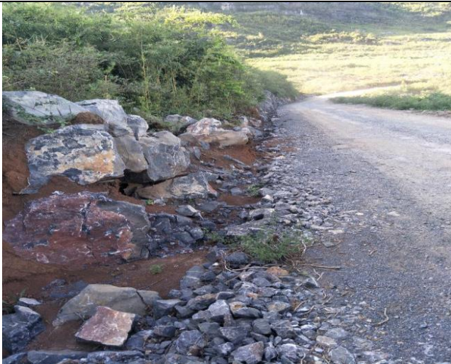
进场道路排水沟施工前
