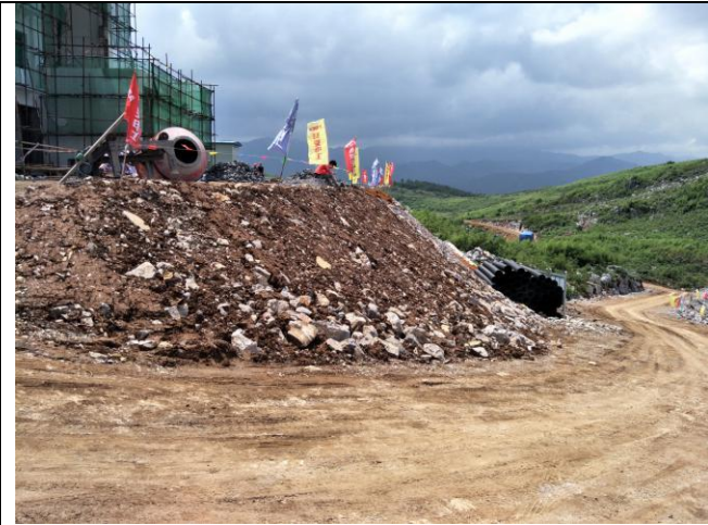
升压站六棱空心砖护坡施工前
