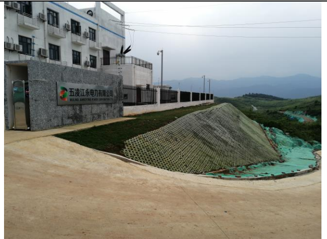
升压站六棱空心砖护坡完工后
