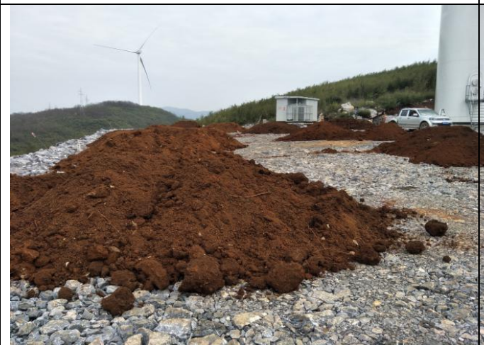
风电机组平台施工前
