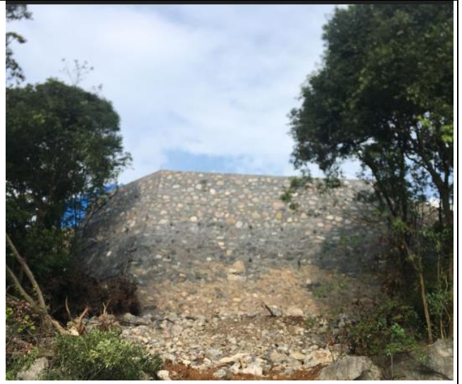
风机平台挡土墙完工后
