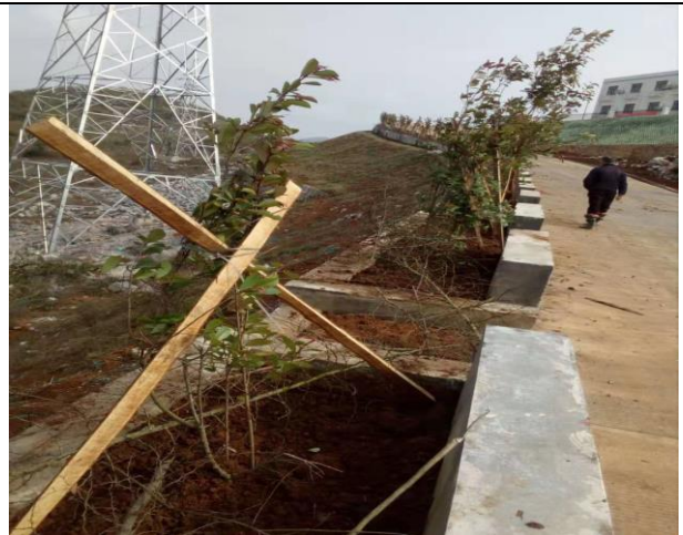
升压站栽植苗木完工后
