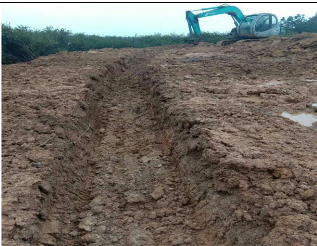
风机平台排水沟施工中
