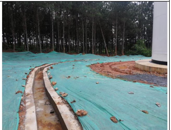
风机平台排水沟完工后
