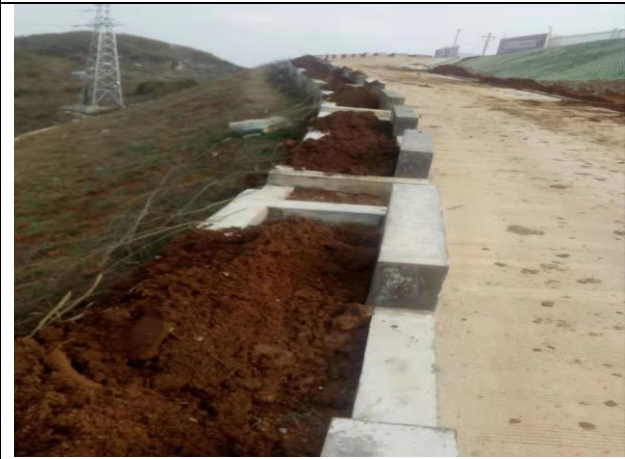
升压站栽植苗木施工前
