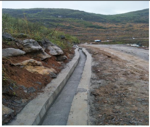
进场道路排水沟完工后
