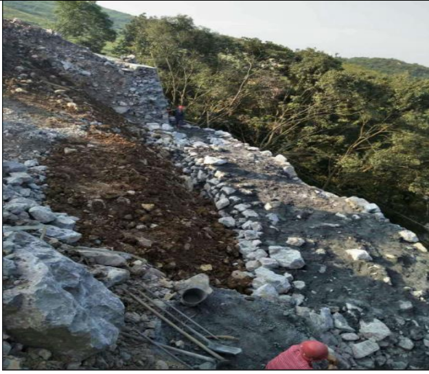
风机平台挡土墙施工中
