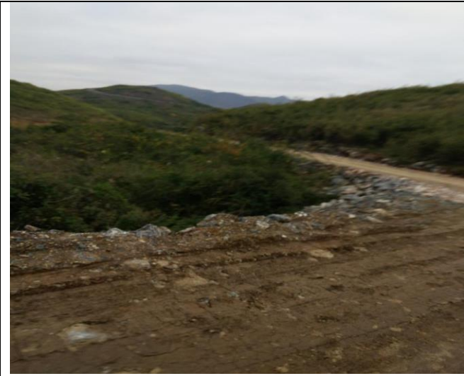
进场道路一侧施工前
