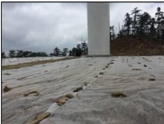
风机平台喷播灌草覆膜绿化
