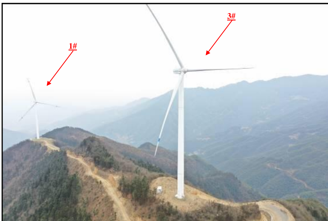
1#、3#风机位航拍照片
