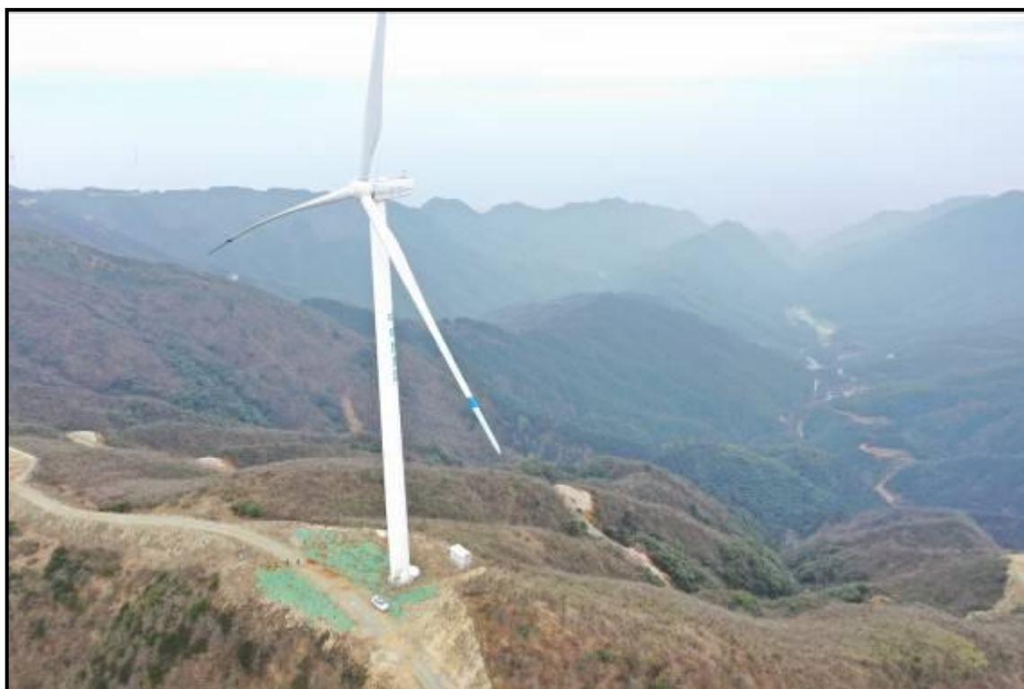
24#风机点位航拍照片
