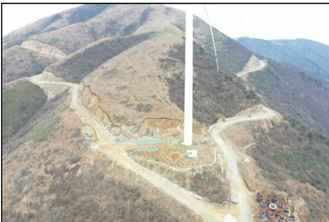
22#风机点位航拍照片
