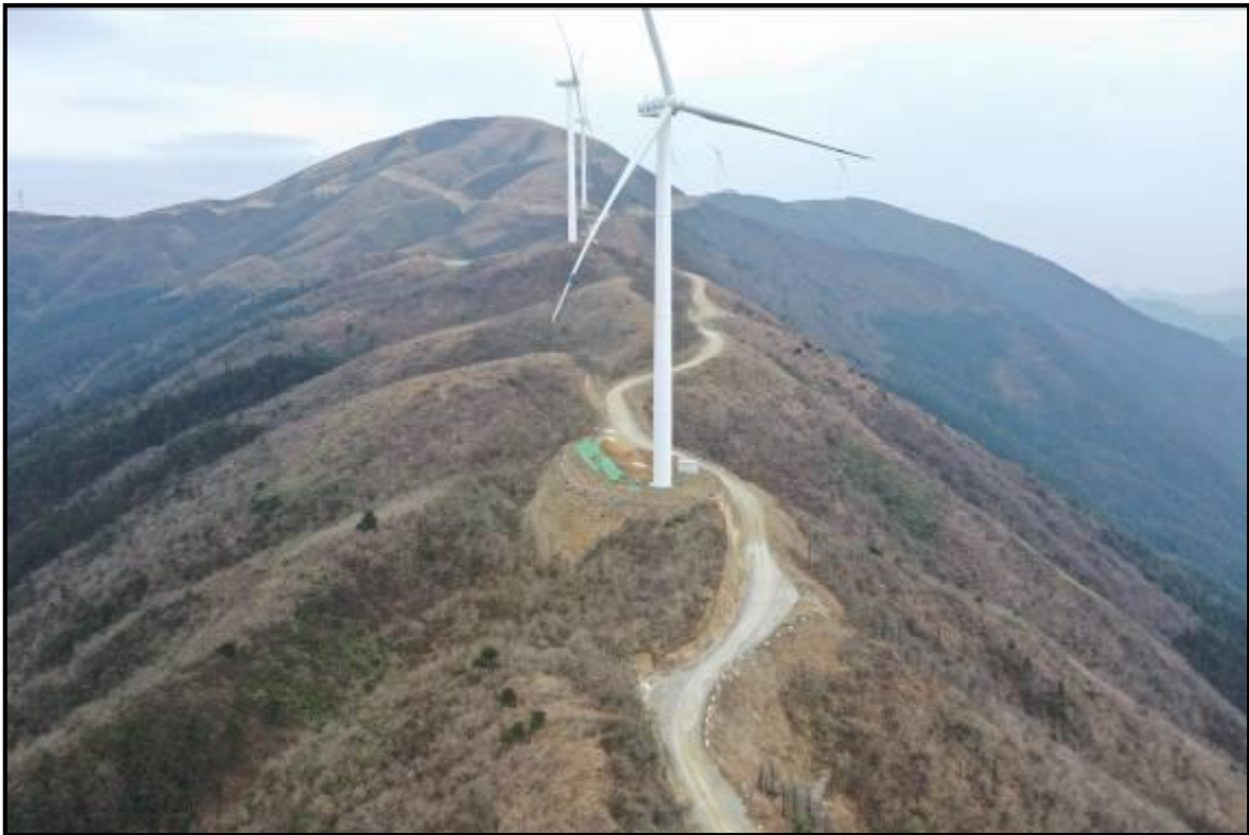
20#风机点位航拍照片
