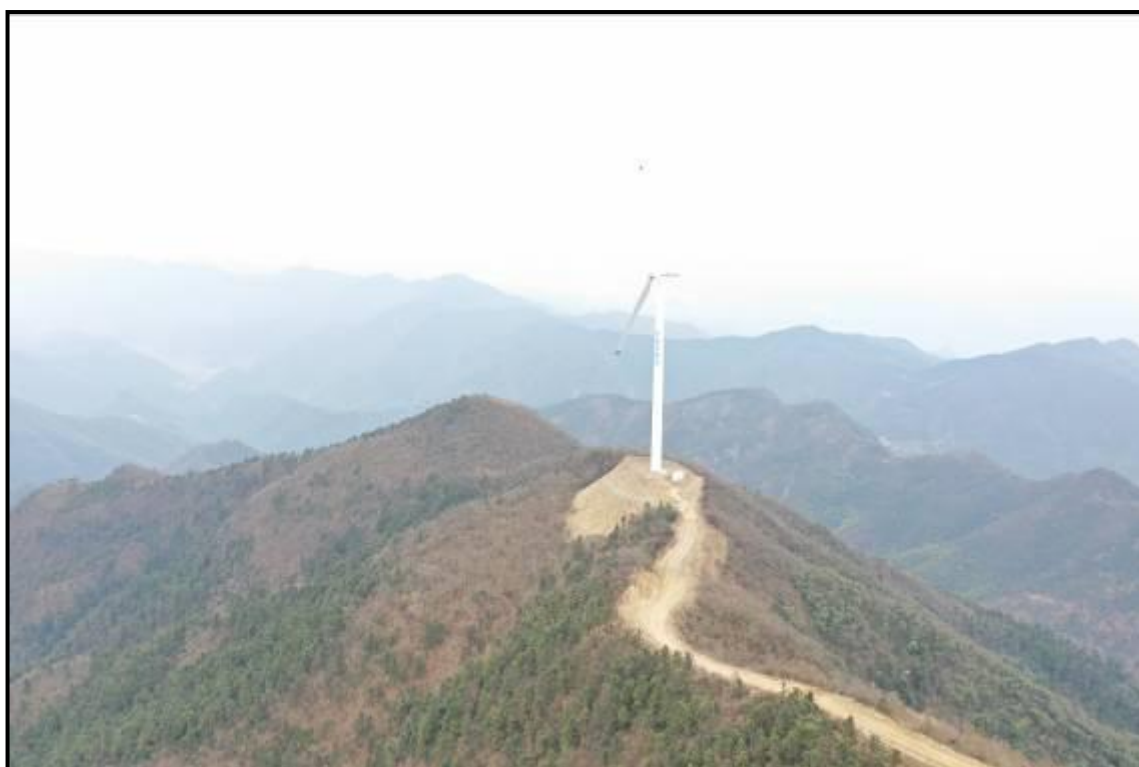
2#风机位航拍照片
