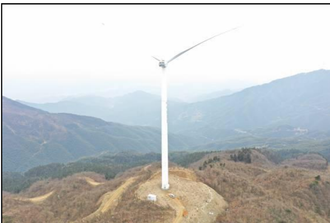
8#风机位航拍照片
