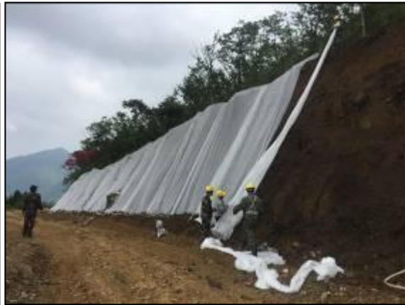
施工期间边坡生态恢复
