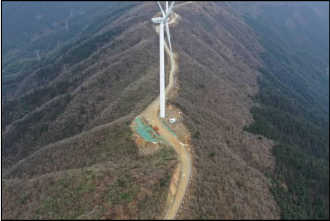
19#风机点位航拍照片
