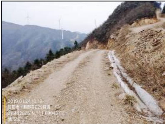
厂内道路混凝土排水沟
