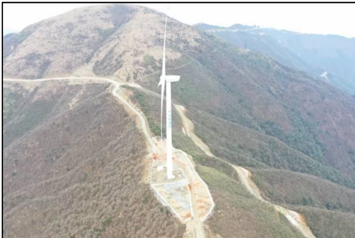
23#风机点位航拍照片
