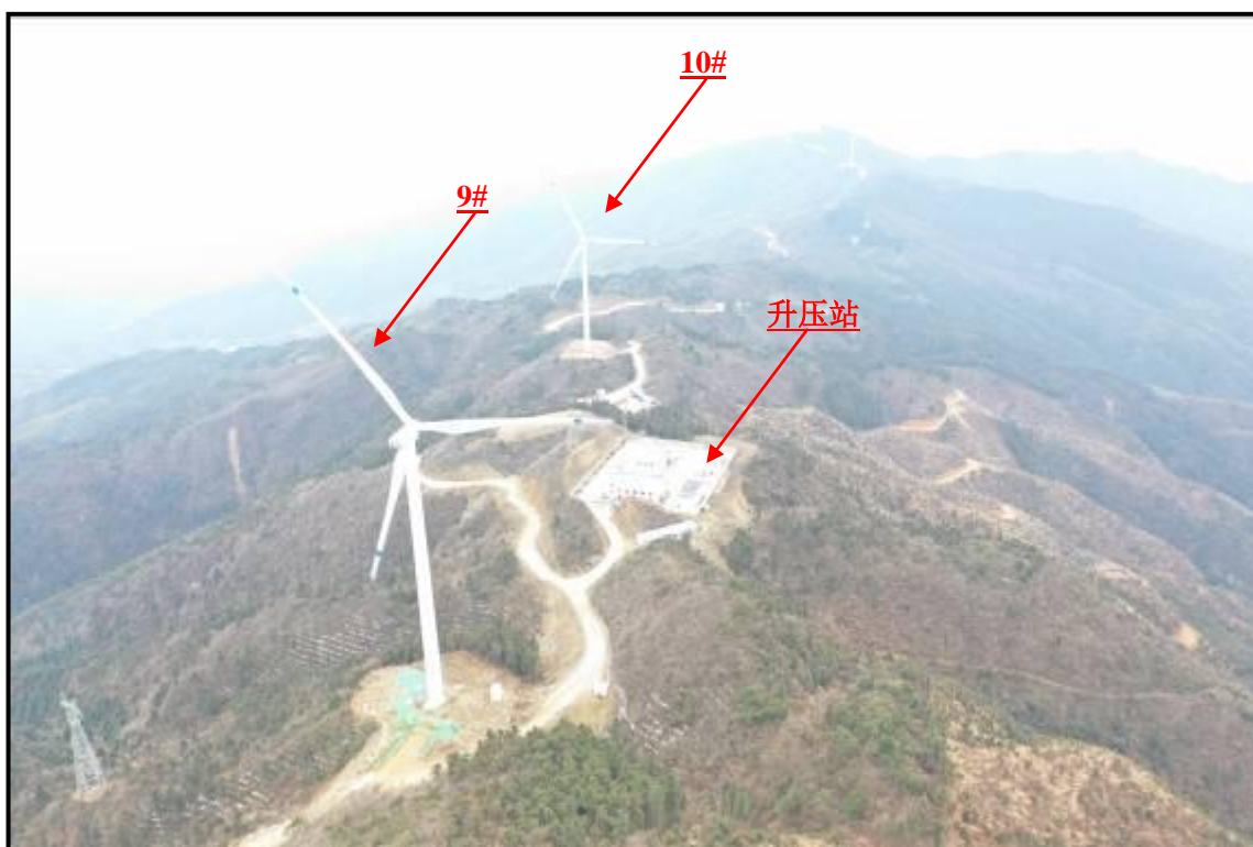
9#、10#风机位、升压站航拍照片
