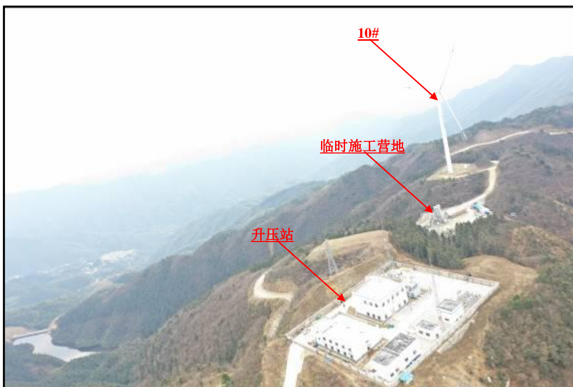
升压站、临时施工营地航拍照片
