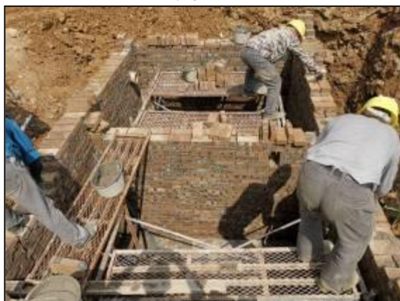
25m 3 的污水暂存池施工照片
