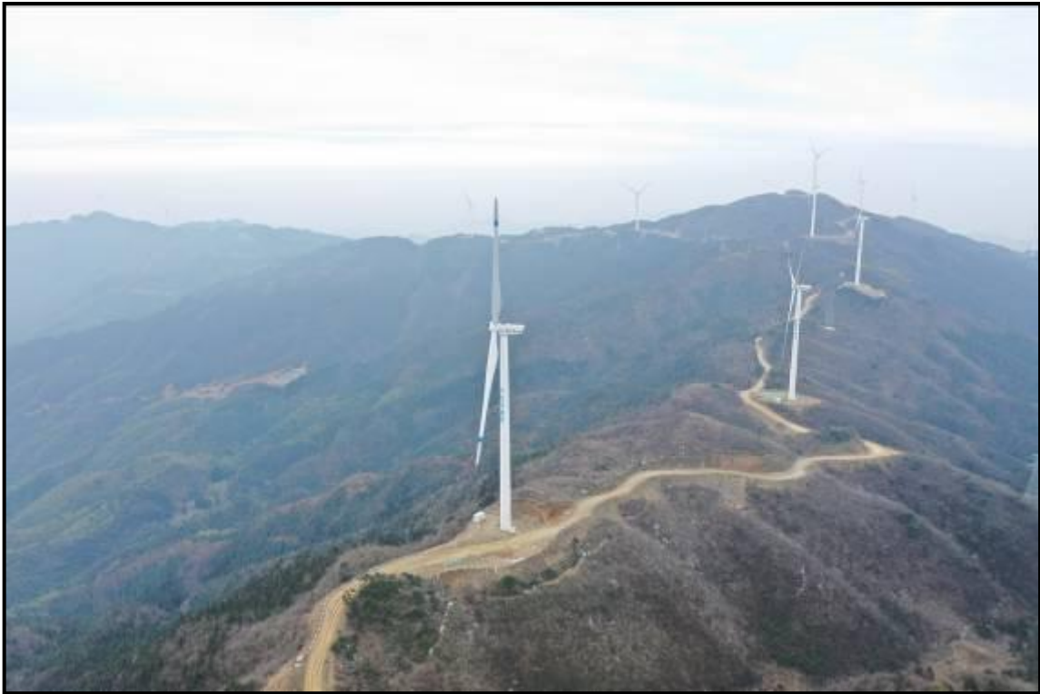
18#风机点位航拍照片
