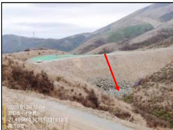
3号渣场及挡墙
