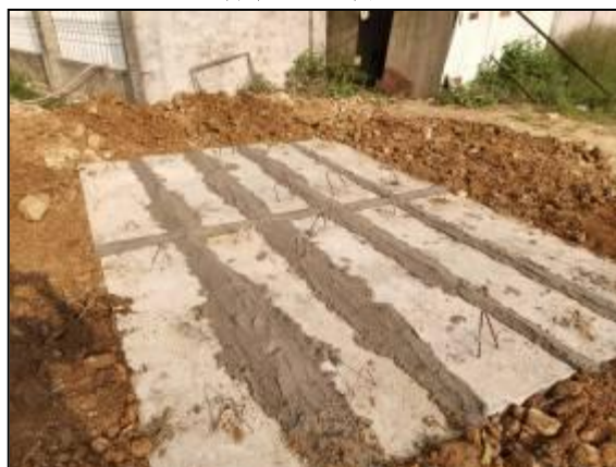
25m 3 的污水暂存池施工完成照片
