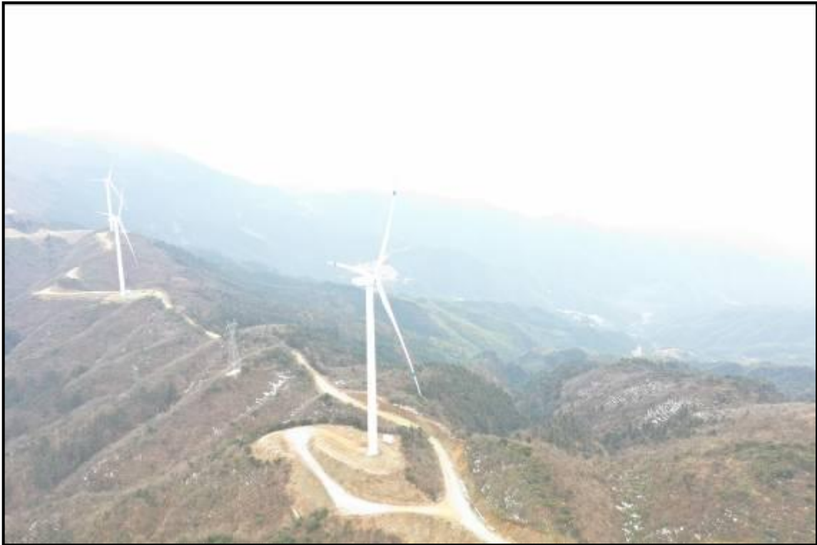
16#风机点位航拍照片
