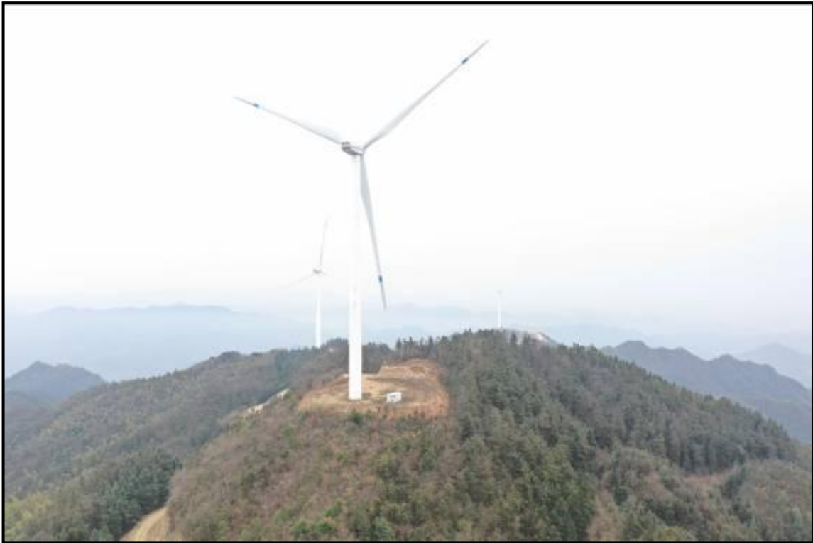
12#风机点位航拍照片
