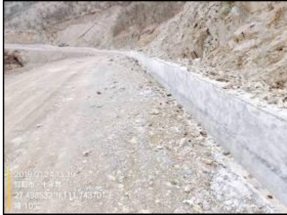
新建浆砌石挡墙
