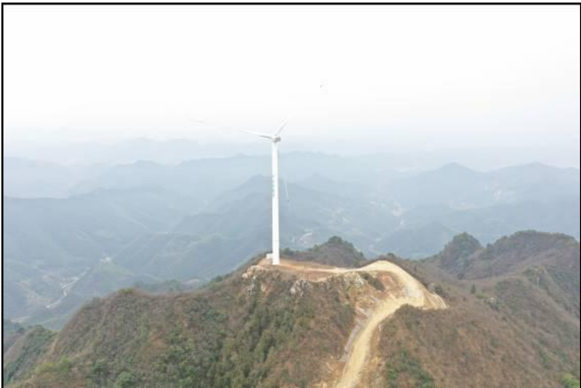
14#风机点位航拍照片
