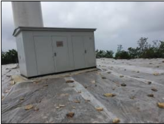
施工期间风机平台生态恢复
