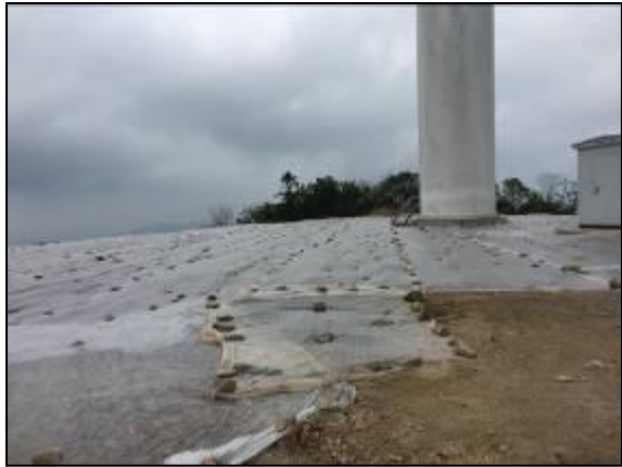
施工期间风机平台生态恢复
