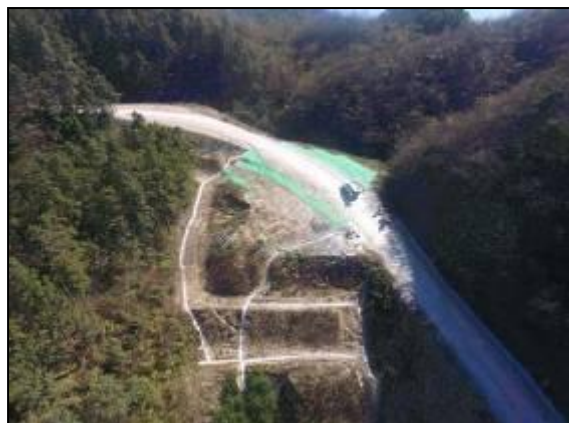
2号渣场及挡墙
