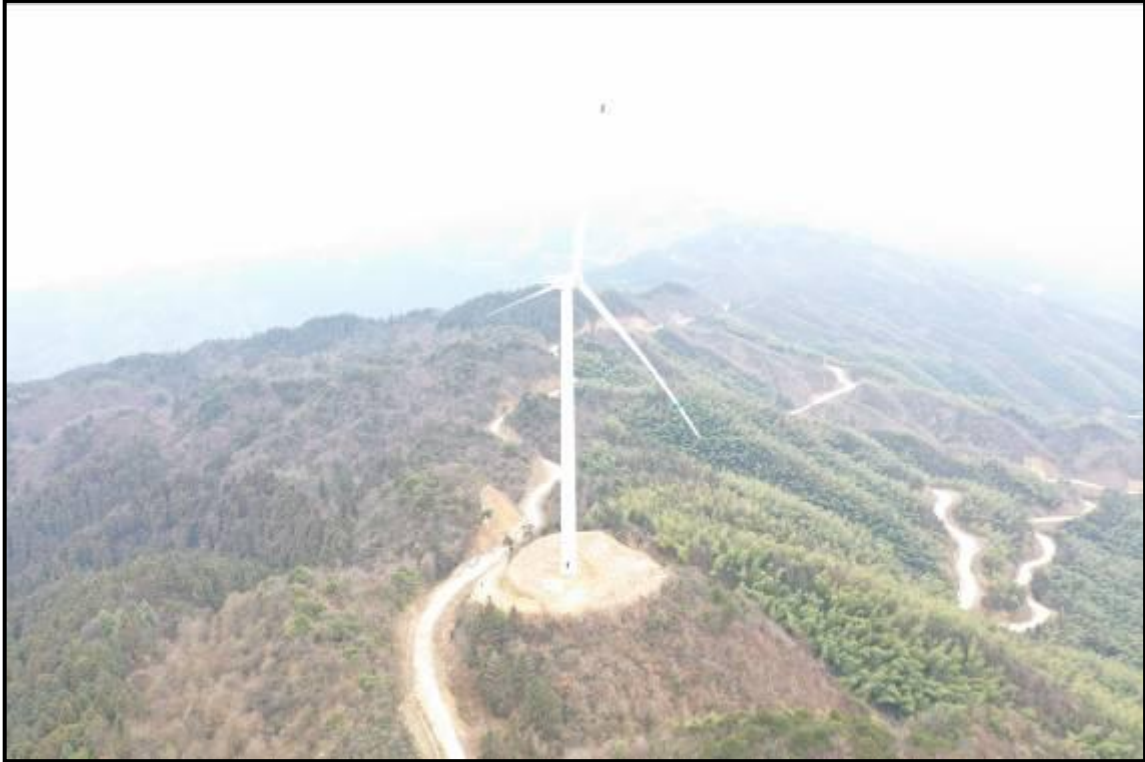
13#风机点位航拍照片
