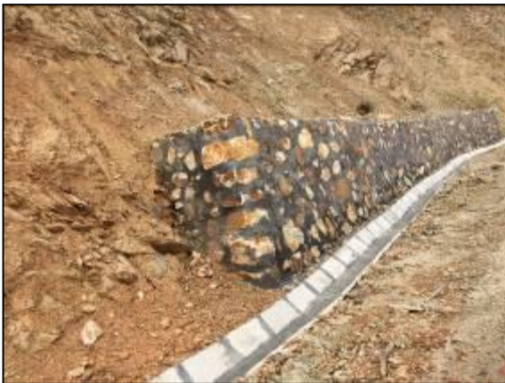
新建挡墙、排水沟
