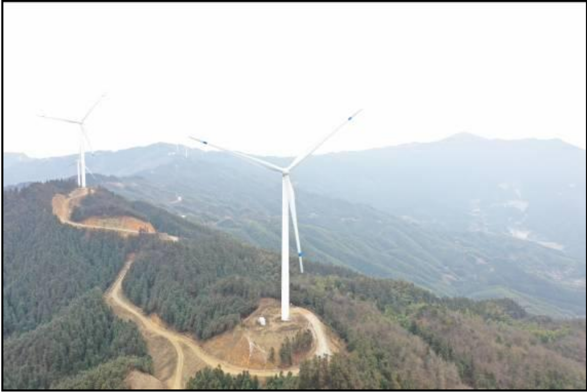
11#风机点位航拍照片
