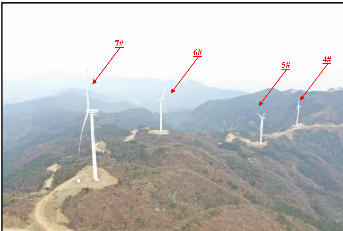
4#~7#风机位航拍照片
