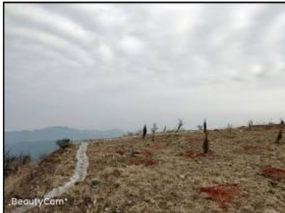
风机平台截排水沟、绿化等
