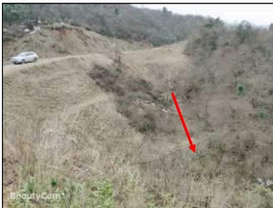
4号渣场及挡墙
