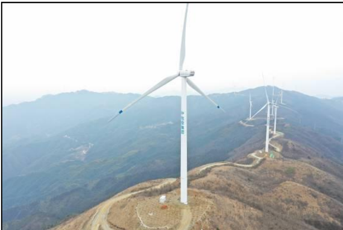
21#风机点位航拍照片
