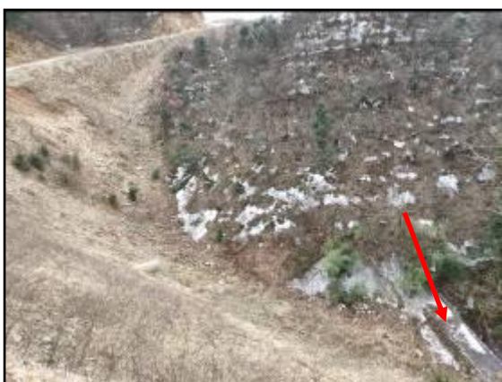
5号渣场及挡墙
