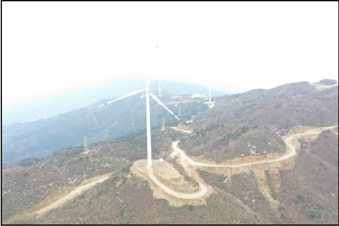
15#风机点位航拍照片
