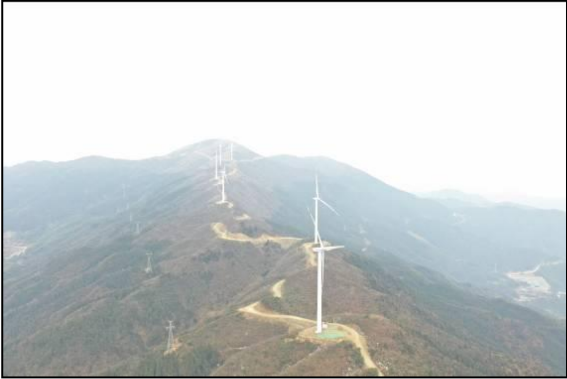
17#风机点位航拍照片
