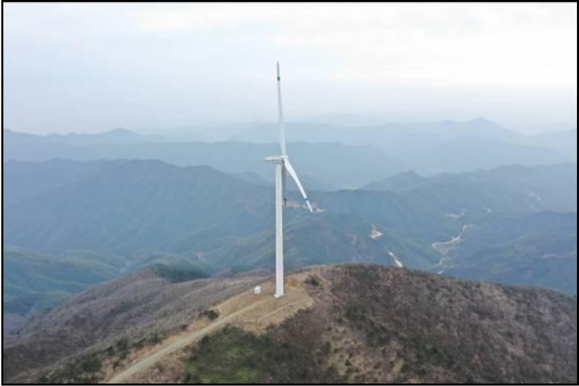
25#风机点位航拍照片
