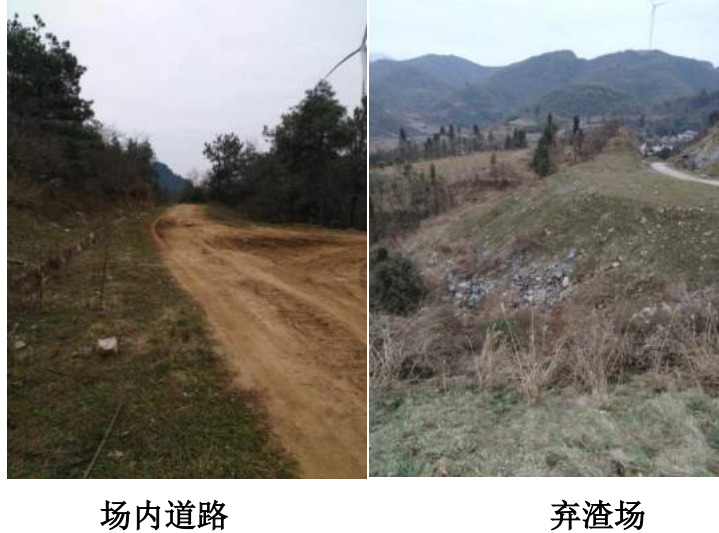
图 3.2-1 永顺大青山风电场实际建设情况图
