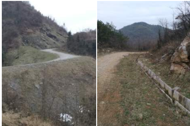
场内道路边坡防护、排水设施和挡土墙
