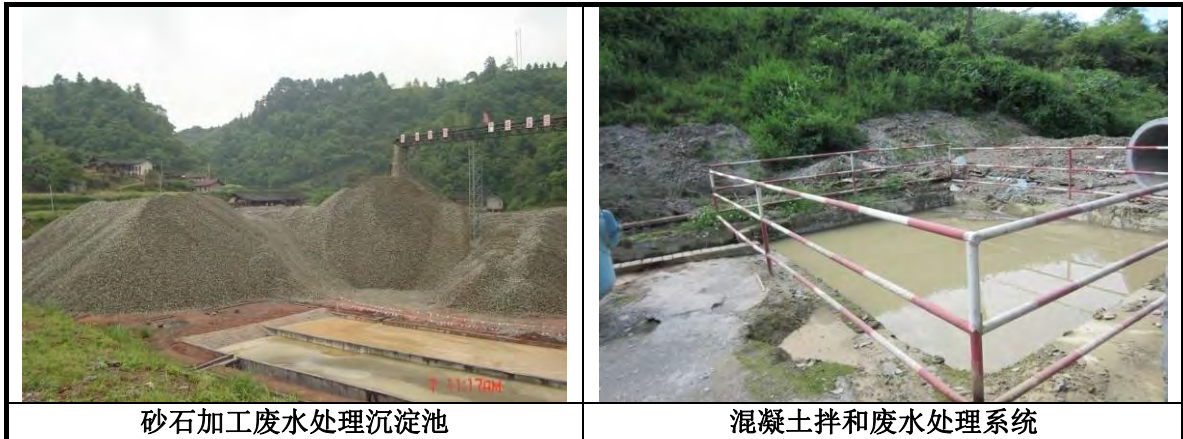
图 4.2-1 生产废水处理系统
