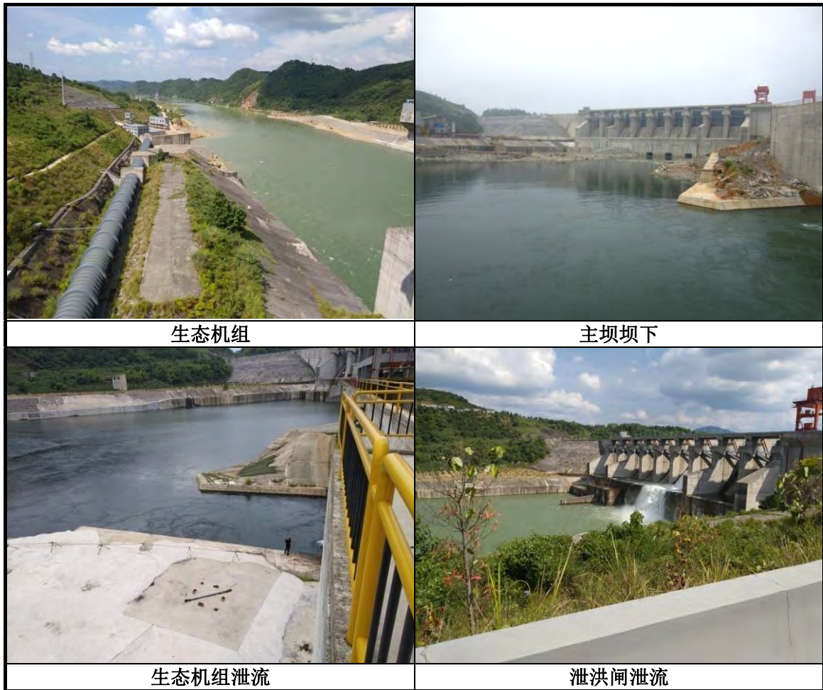
图 5.1-11 生态机组运行情况
