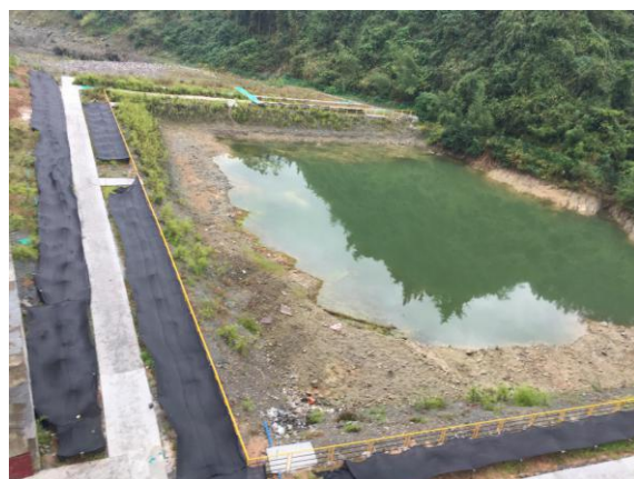
大坝右岸回填区
