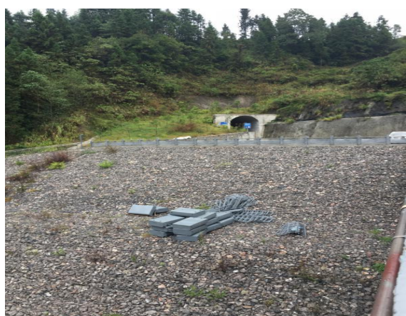
交通洞口边坡
