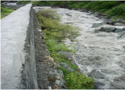
田湾沟泥石流防护堤
