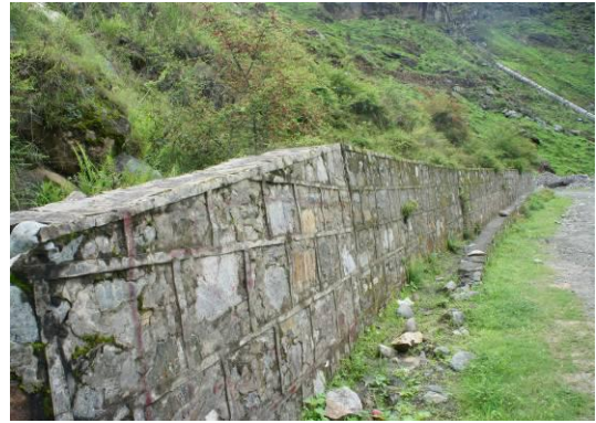
4#渣场挡墙及排水沟
