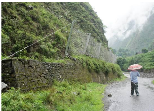
道路浆砌石护坡
