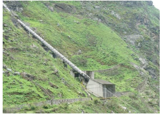
压力管道边坡防护
