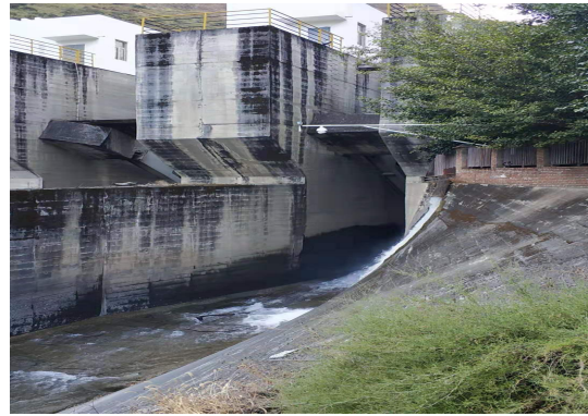
冲砂闸门前在线监控设施
