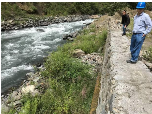
3#渣场临河侧挡墙
