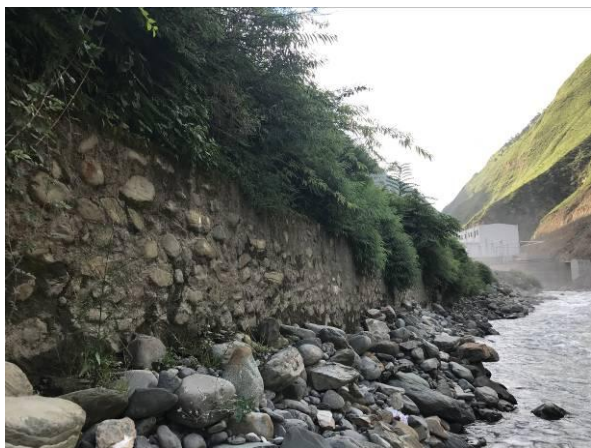
4#渣场临河侧挡墙
