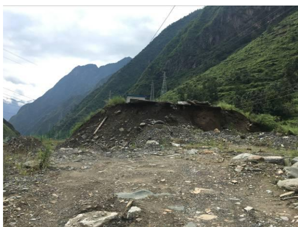
4#渣场平整过程
