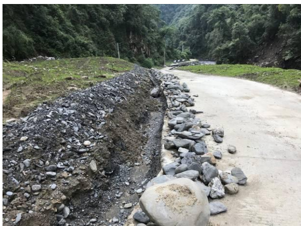
1#渣场排水沟施工
