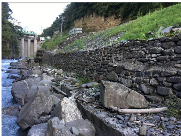
1#渣场临河侧挡墙
