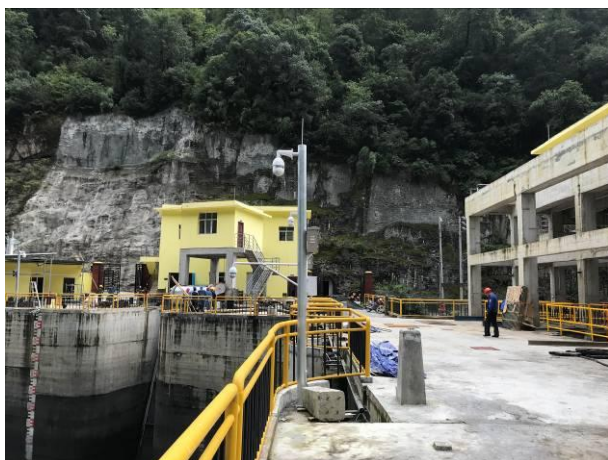
大坝左坝肩挂网砼护坡
