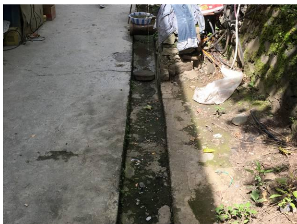
2#支洞口工区排水沟
