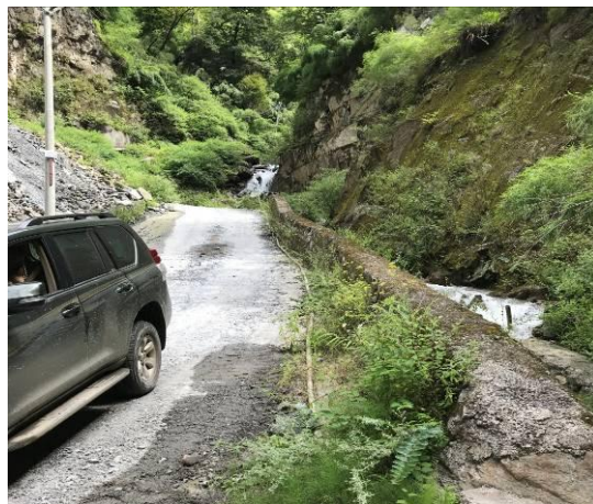
浆砌石排水沟
