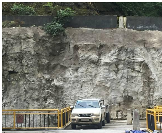
大坝右坝肩护坡及挡墙
