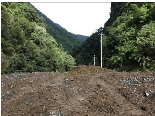
2#渣场覆土过程
