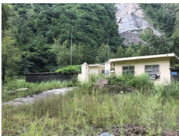
炸药库移交及场地迹地恢复
