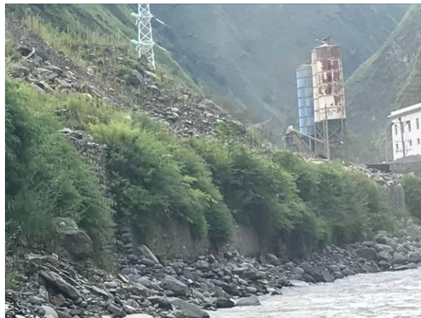
4#渣场临河侧挡墙
