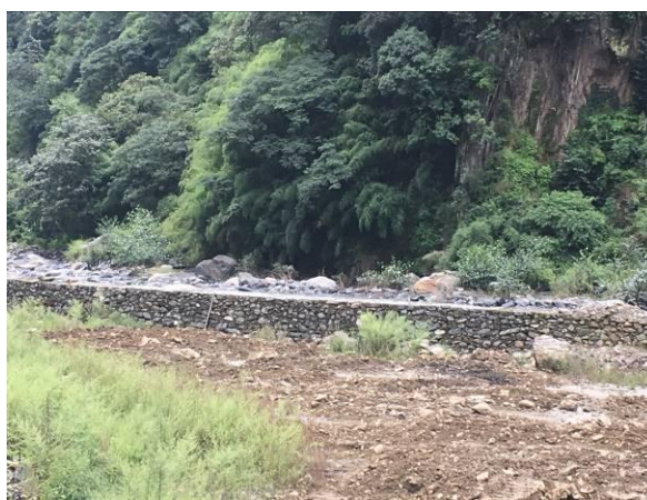
2#渣场下方挡墙
