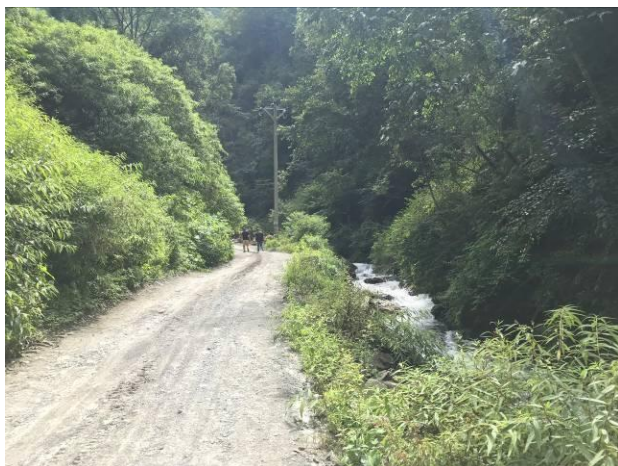
2#支洞施工道路排水沟
