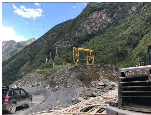
4#渣场平整过程
