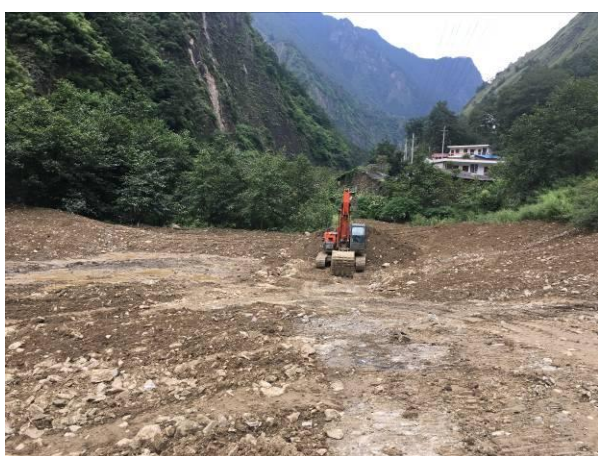
3#渣场覆土过程
