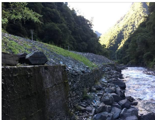
1#渣场临河侧挡墙
