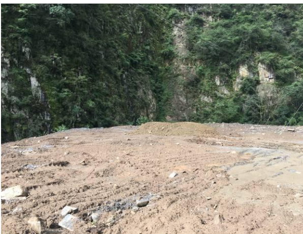
2#渣场绿化进行中
