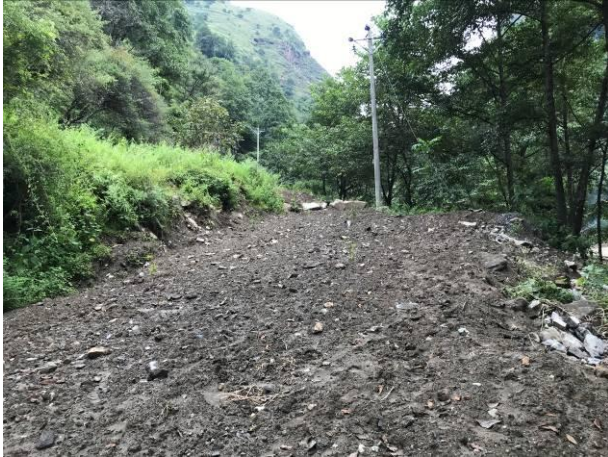
2#支洞施工道路覆土绿化
