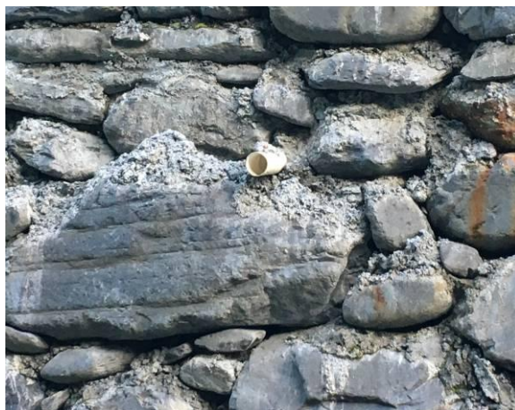
1#渣场挡墙排水孔
