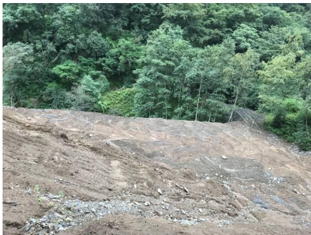
1#支洞施工场地迹地恢复
