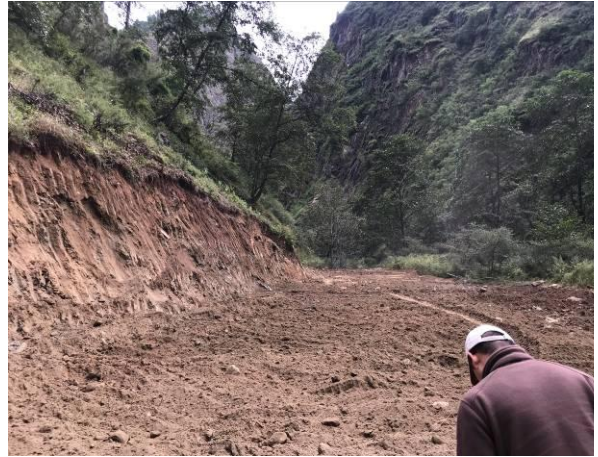
3#支洞施工道路覆土绿化
