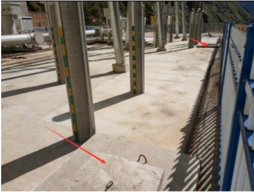
麻窝电站 110kV 升压站事故油池检查口
