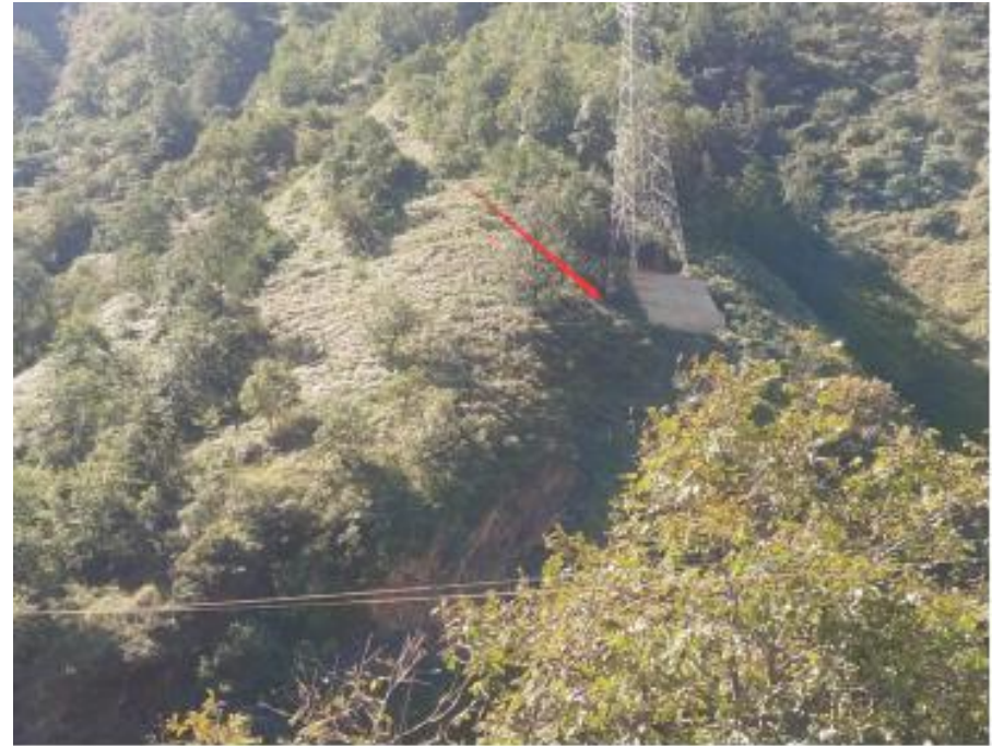
沿线塔基周边裸土已完成植物恢复措施，植被恢复较好
