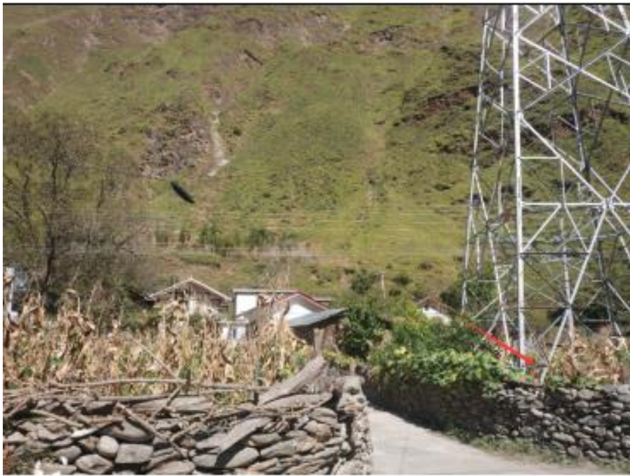
9#塔基占地已完成复垦，农作物生长较好
