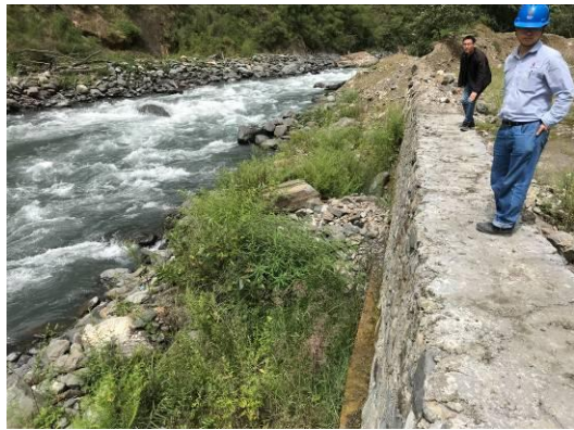
3#渣场临河挡墙
