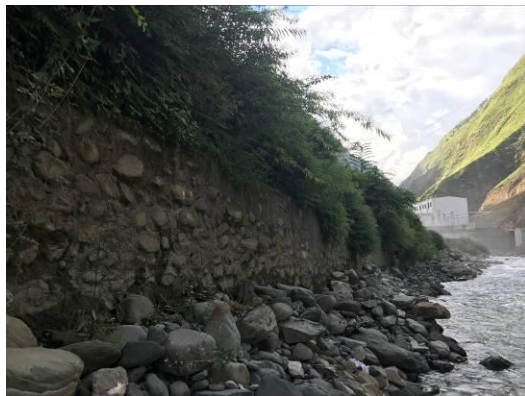
4#渣场外侧挡墙
