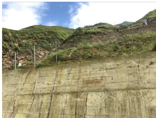
2#施工道路铁丝防护网
