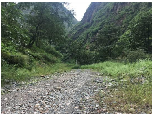
3#支洞施工道路平整及两侧绿化
