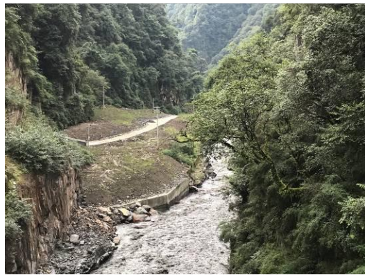
1#渣场临河侧挡墙
