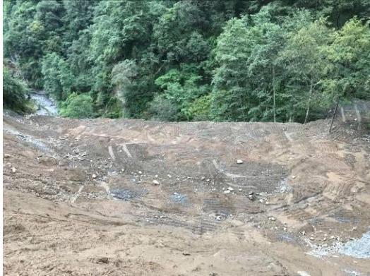
1#支洞施工营区迹地恢复
