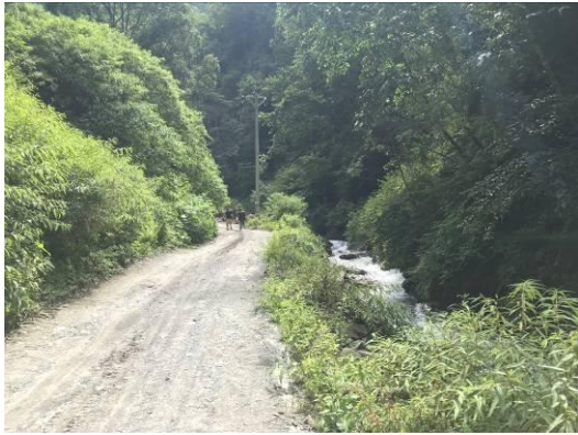
2#支洞施工道路排洪沟及绿化（前期）
