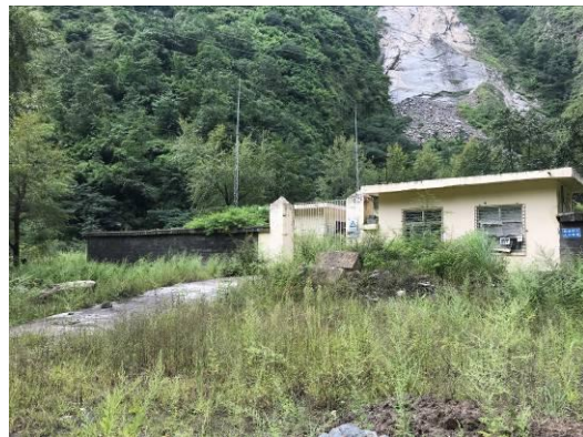
炸药库移交及场地外迹地恢复
