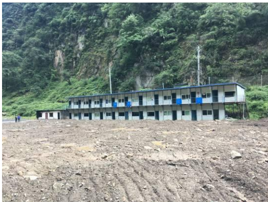
1#施工营地迹地恢复
