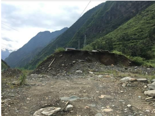
4#渣场平整过程
