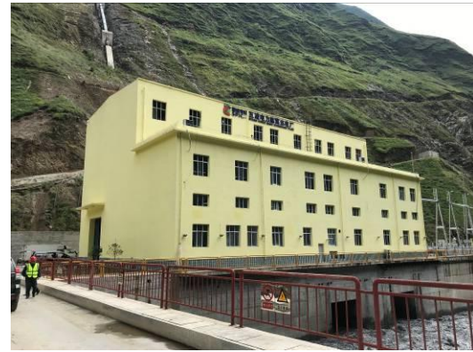
厂区枢纽入口及进场道路
