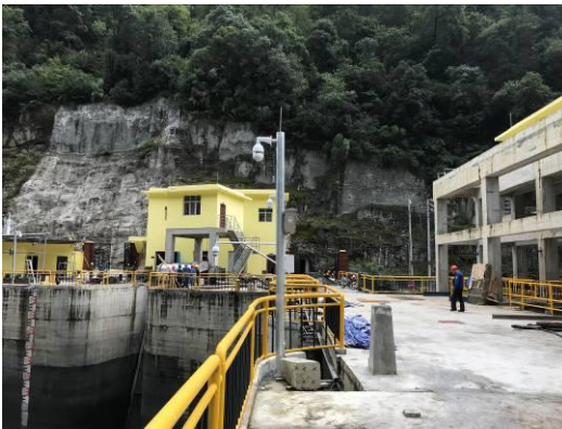
大坝左肩砗护坡
