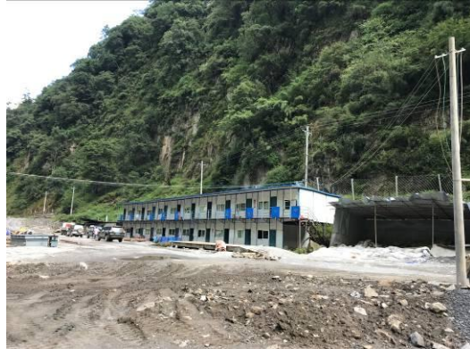
1#施工营地原貌
