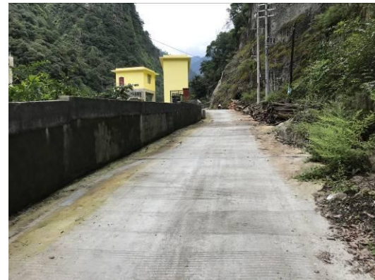
坝区进场道路及挡墙
