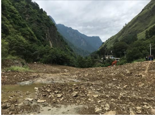
3#渣场平整过程
