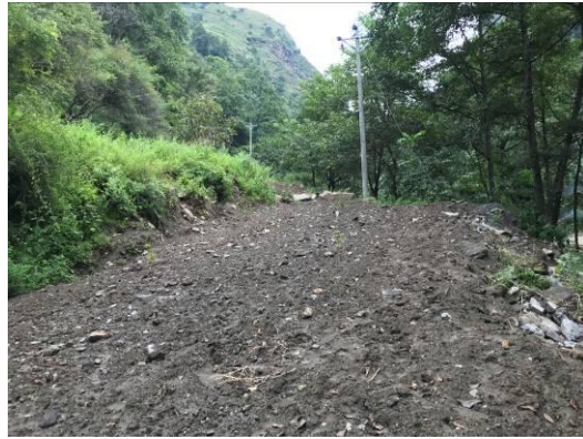
2#支洞施工公路两侧绿化
