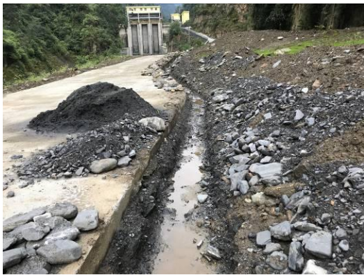
1#渣场排水沟修复施工
