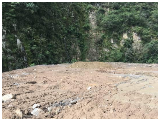
2#渣场现貌（绿化中）
