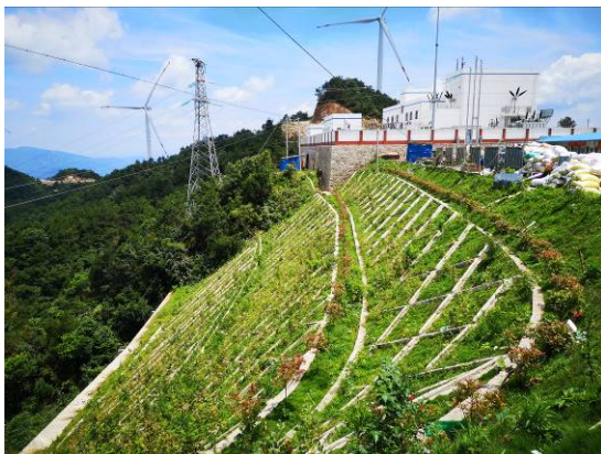
升压站边坡绿化
