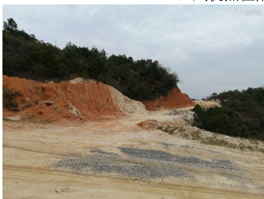
10#风机点位附近村民修筑的道路
