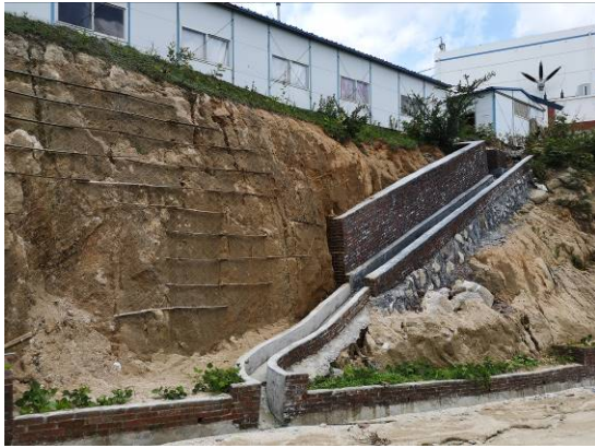
挂网、支护、喷播灌草施工
