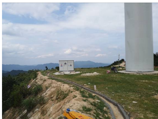
修筑风机平台截排水沟
