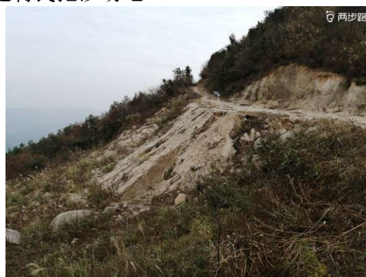
4#风机点位附近村民修筑的道路
