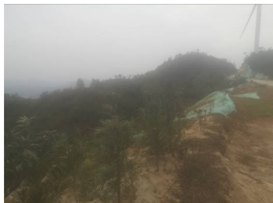
风机平台边坡覆绿
