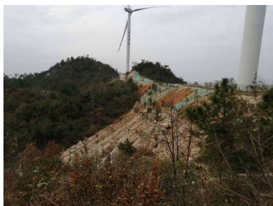
1#弃渣场植被边坡和覆绿
