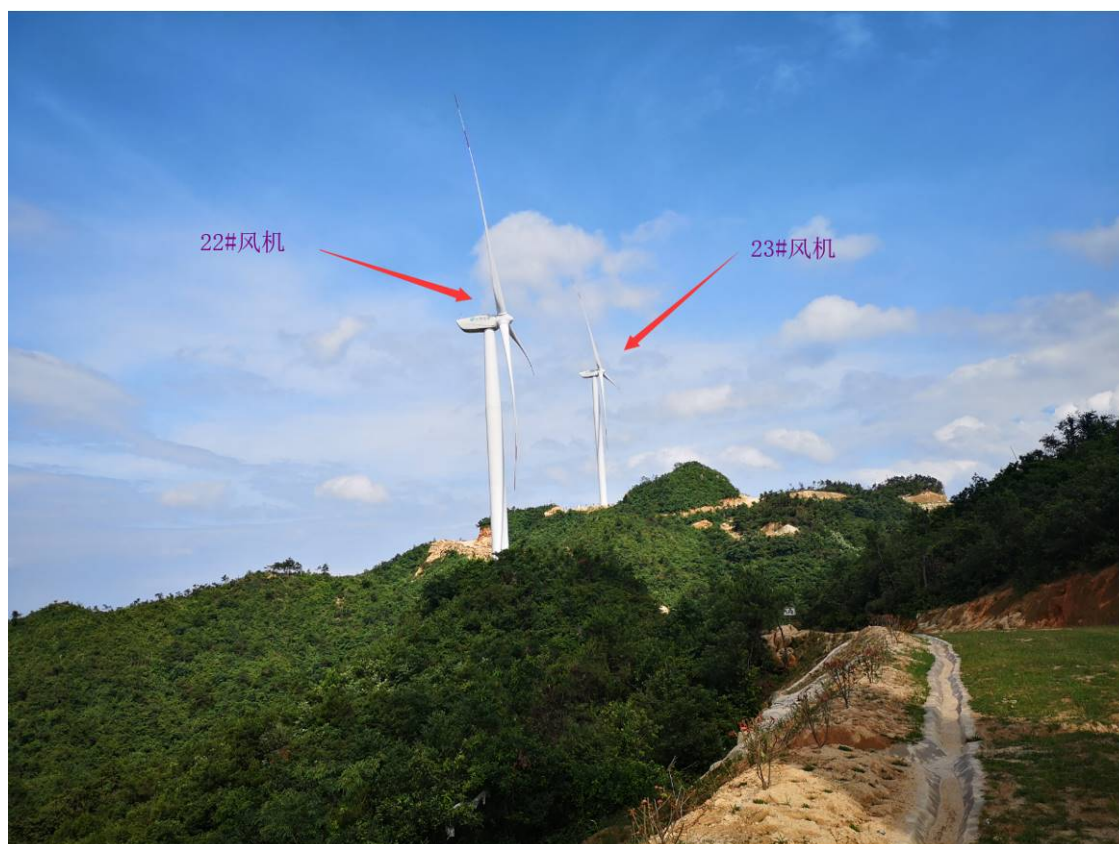
图 2.10-1 风机点位现场照片
