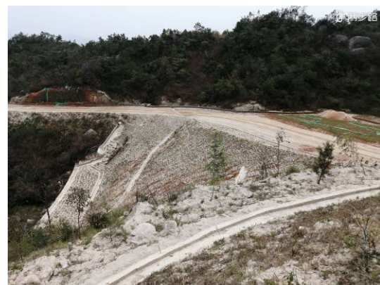
3#弃渣场边坡和覆绿
