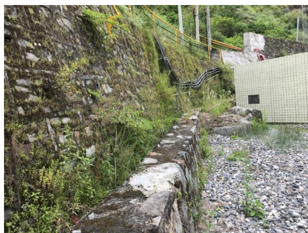
河口变电站区内
