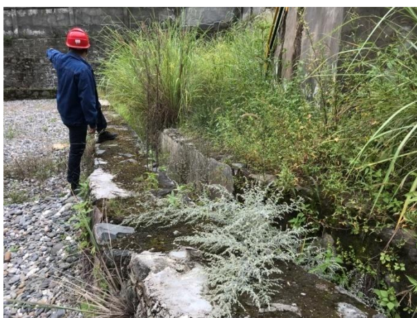
河口变电站区内
