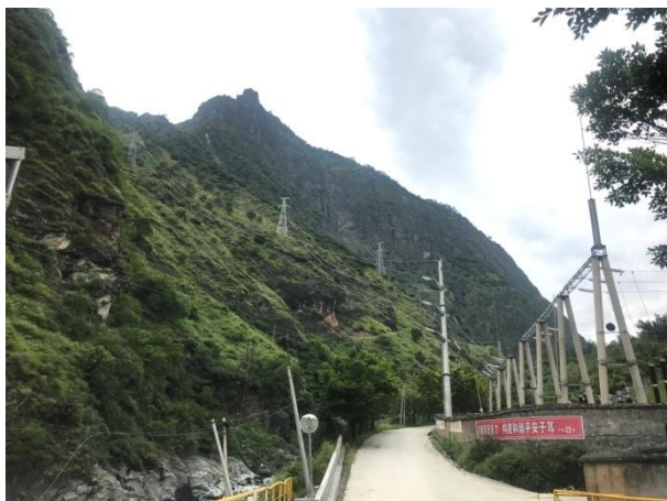
变电站进出线路
