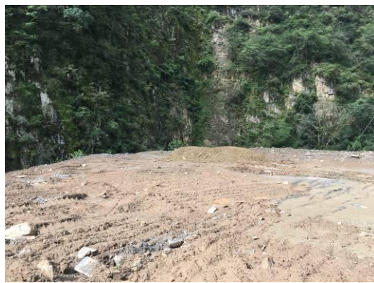
2#渣场现貌（绿化中）
