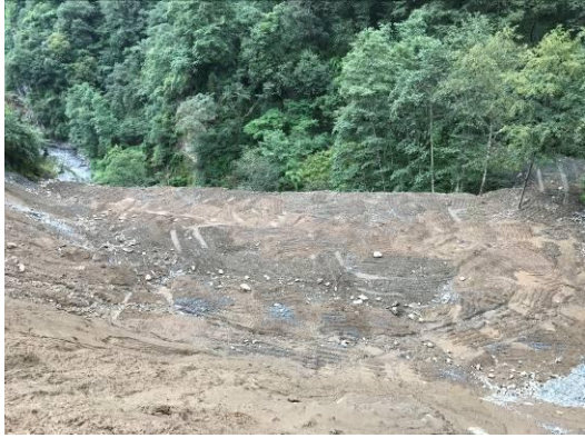
1#支洞施工营区迹地恢复
