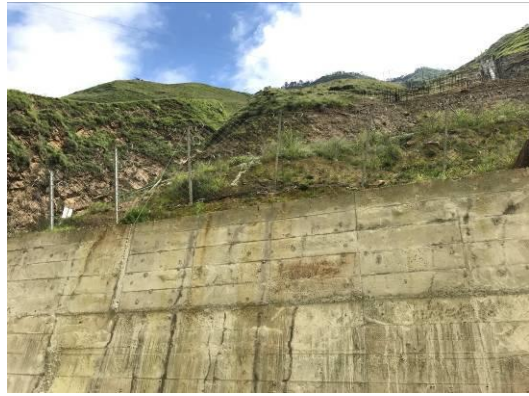
2#施工道路铁丝防护网
