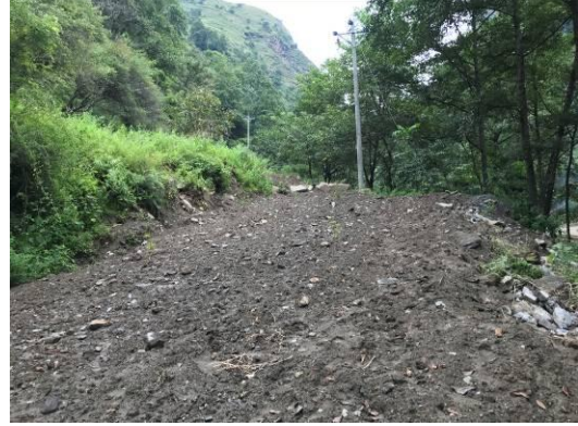
2#支洞施工公路两侧绿化
