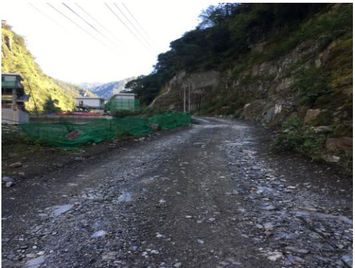
坝区进场道路（前期）
