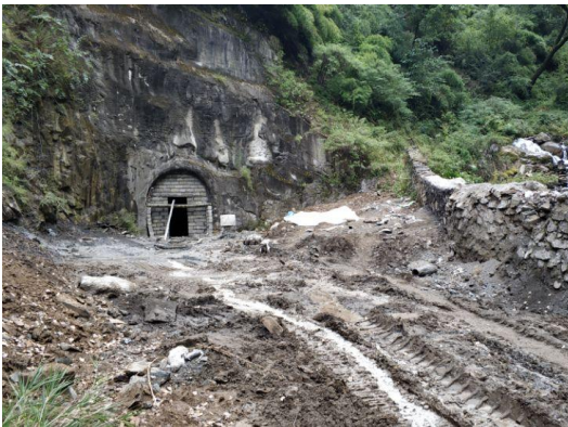
3#支洞 (后期封堵)
