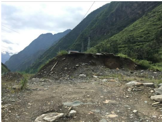
4#渣场平整过程
