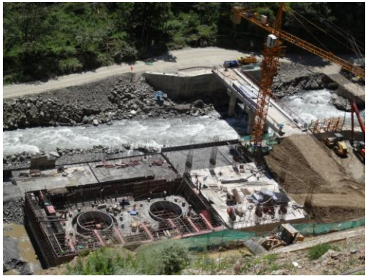
厂区枢纽入口及进场道路 (前期)
