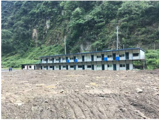
1#施工营地迹地恢复
