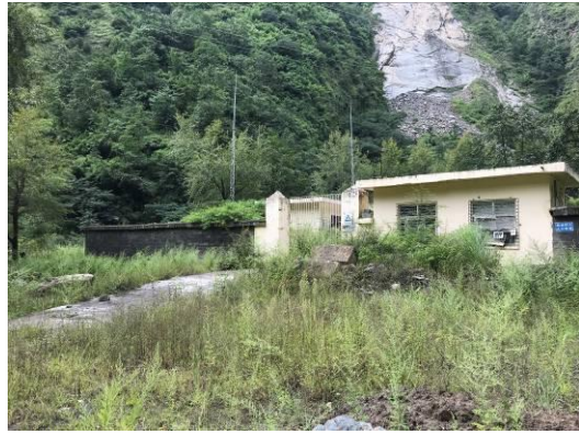
炸药库移交及场地外迹地恢复
