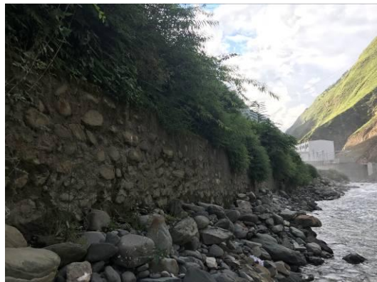
4#渣场外侧挡墙
