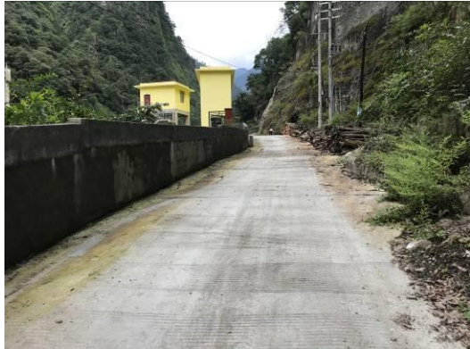
坝区进场道路及挡墙（后期）
