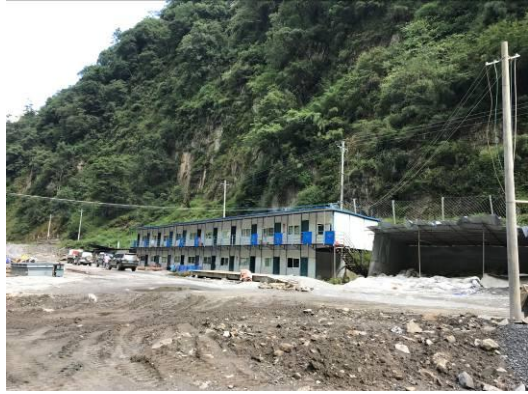
1#施工营地原貌
