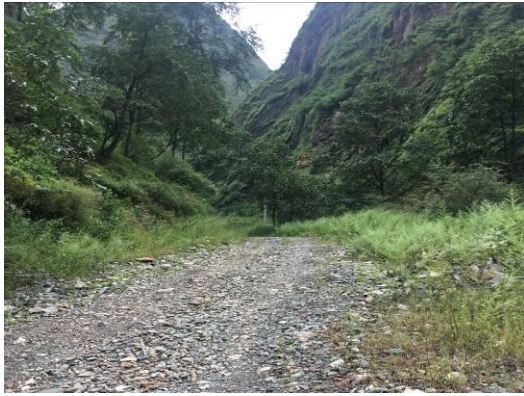
3#支洞施工道路平整及两侧绿化
