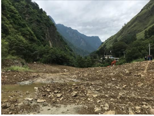
3#渣场平整过程
