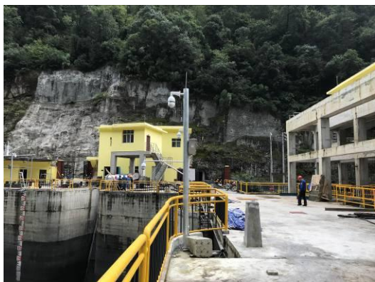
大坝左肩砗护坡
