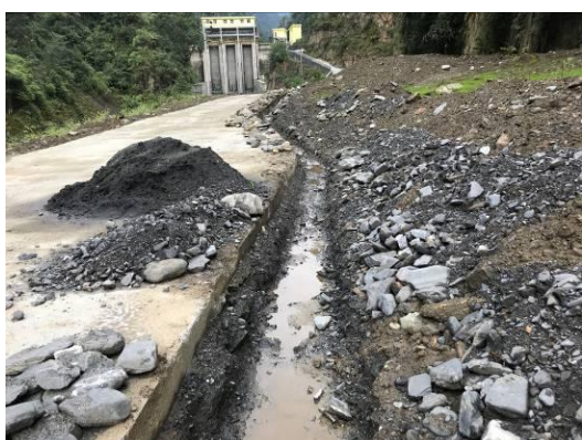
1#渣场排水沟修复施工
