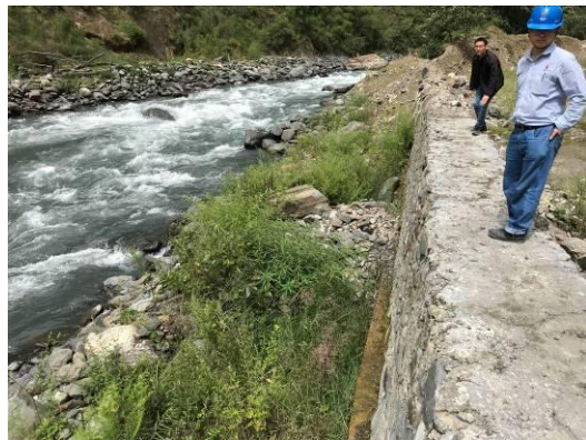
3#渣场临河挡墙
