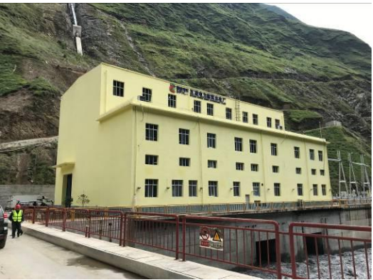
厂区枢纽入口及进场道路 (后期)
