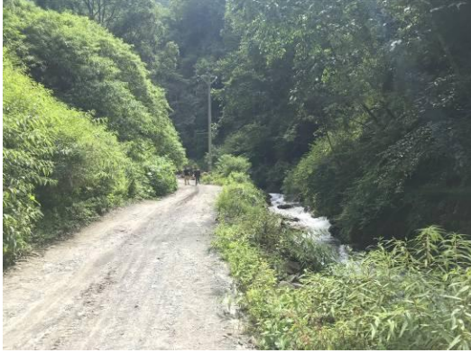
2#支洞施工道路排洪沟及绿化（前期）
