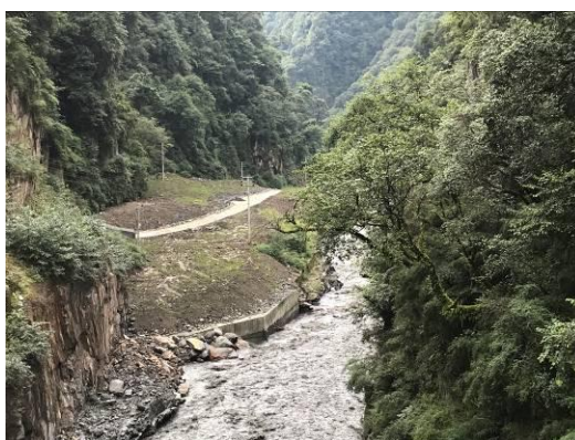
1#渣场临河侧挡墙
