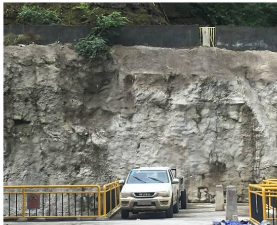
大坝右坝肩护坡及挡墙
