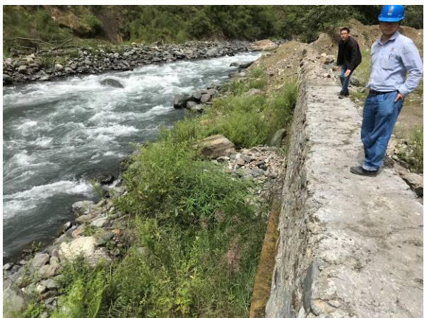
3#渣场临河侧挡墙
