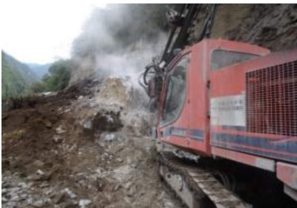
上坝公路土石方开挖
