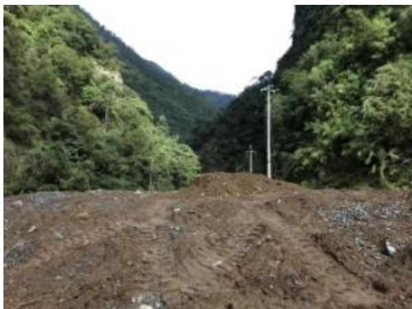
2#渣场场地平整覆土
