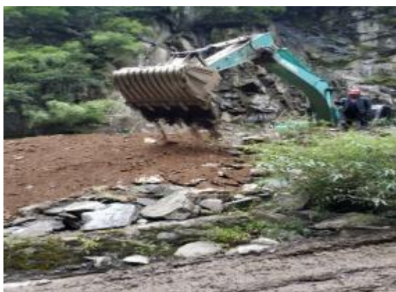
3#支洞场地平整及覆土
