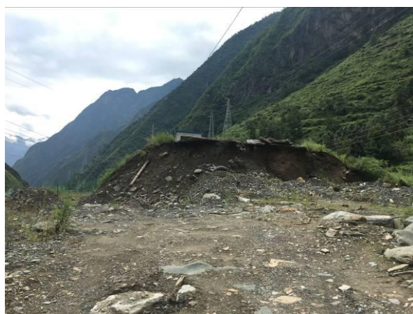
4#渣场平整过程
