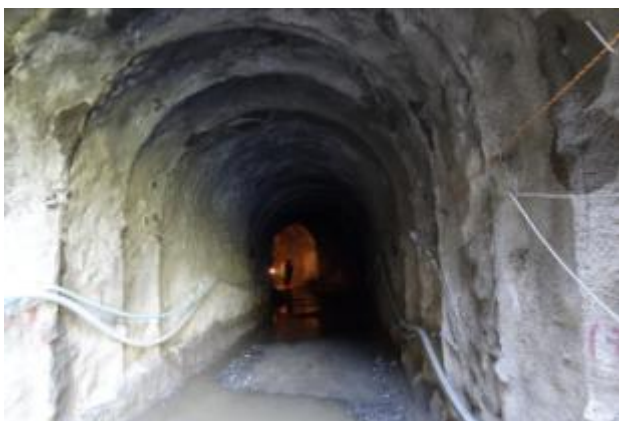
1#施工支洞洞内支护
