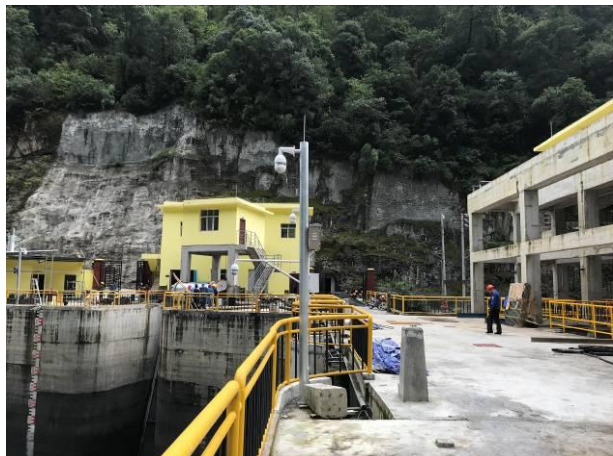
大坝左坝肩挂网砼护坡
