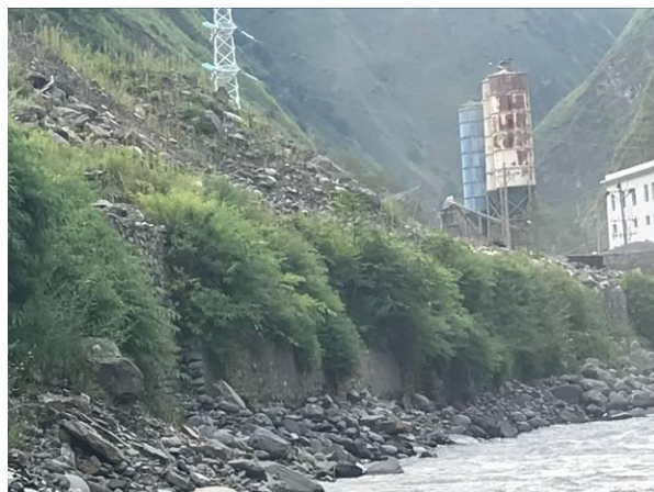
4#渣场临河侧挡墙
