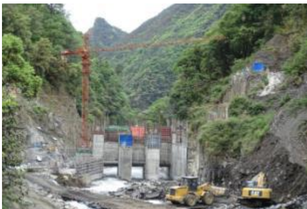
首部枢纽边坡清理
