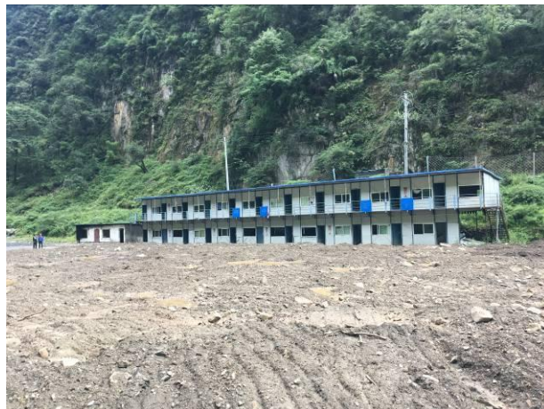
1#施工营地迹地恢复
