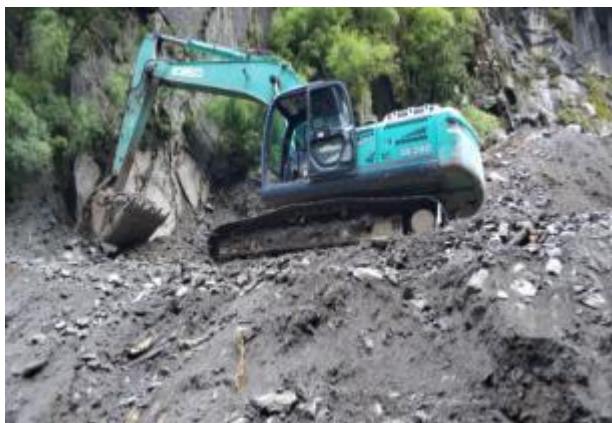
2#支洞外场地平整
