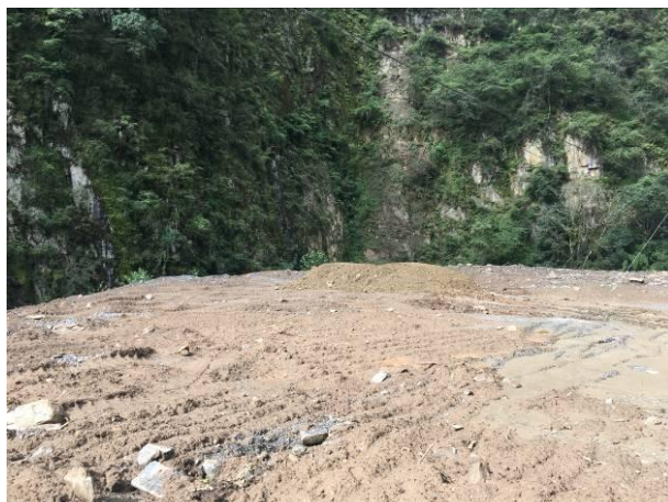
2#渣场绿化进行中
