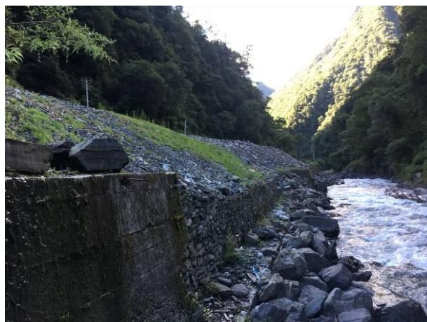
1#渣场临河侧挡墙
