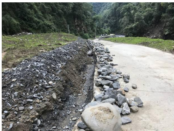
1#渣场排水沟施工
