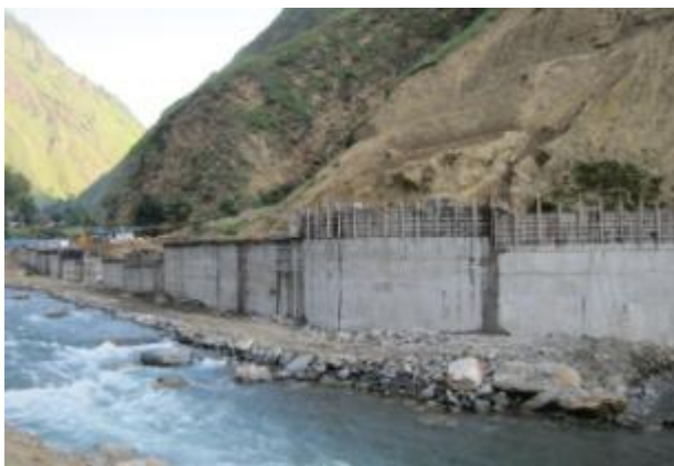
厂房防洪墙混凝土浇筑施工
