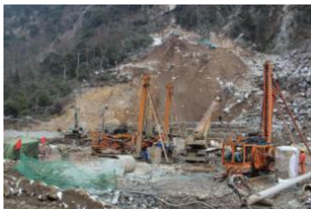
首部枢纽左岸坝肩开挖
