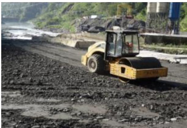
回填碾压施工现场图
