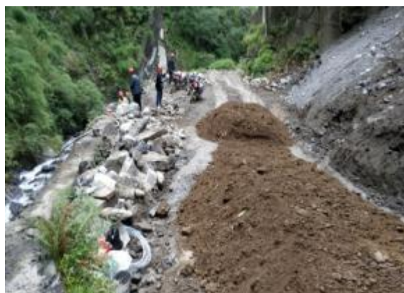
2#支洞临时道路覆土
