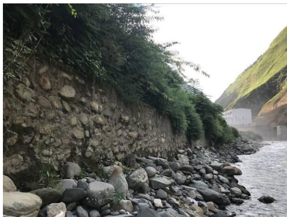
4#渣场临河侧挡墙
