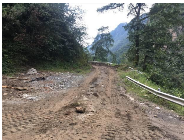
1#支洞口道路土地平整
