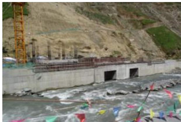
厂房防洪挡墙
