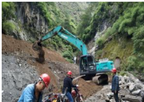
2#支洞临时施工用地平整及覆土
