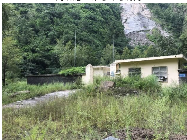
炸药库移交及场地迹地恢复
