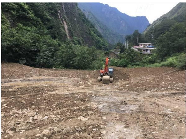
3#渣场覆土过程
