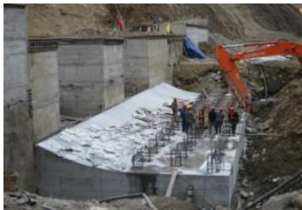
尾水渠消力塘施工现场
