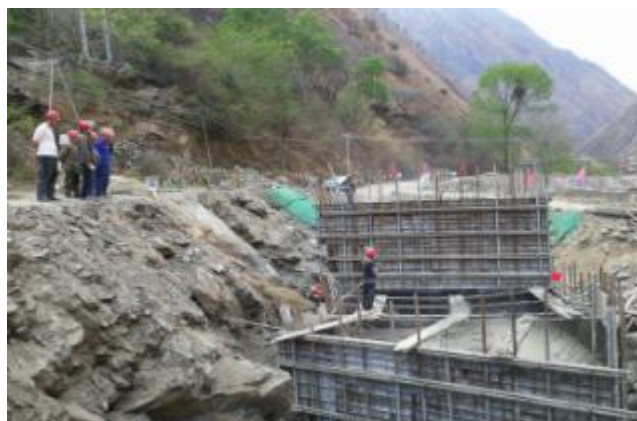
厂房永久交通桥桥台挡墙
