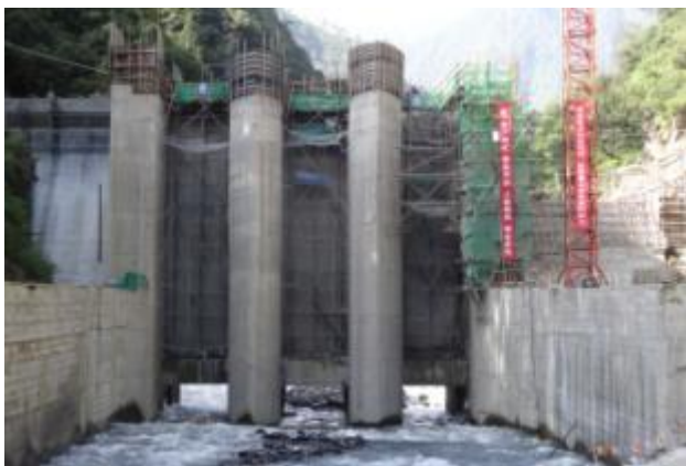
首部枢纽形象进度
