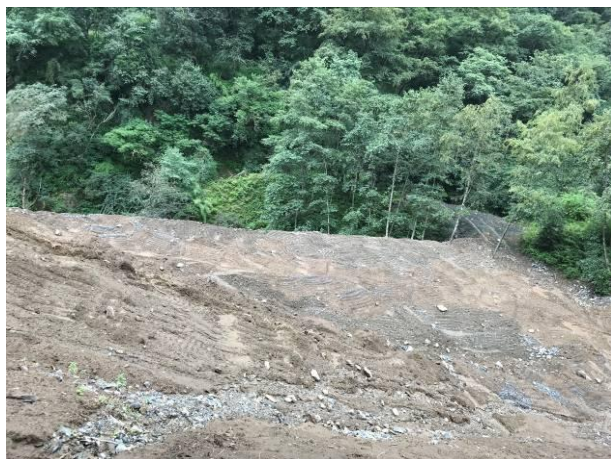
1#支洞施工场地迹地恢复
