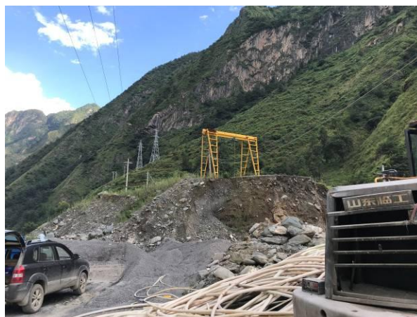
4#渣场平整过程
