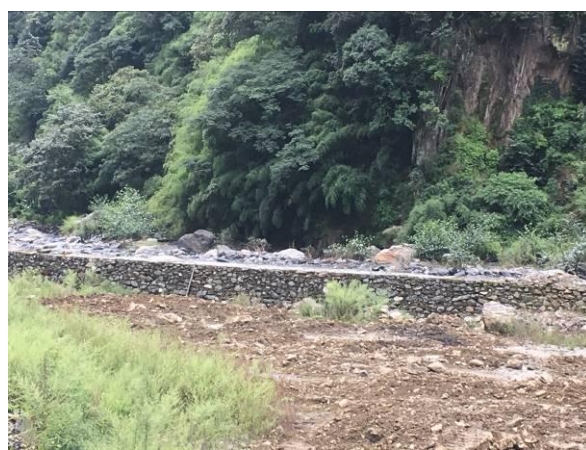
2#渣场下方挡墙
