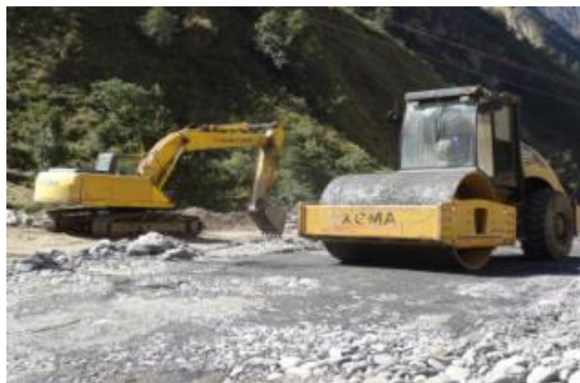
厂房砂卵石回填碾压试验施工
