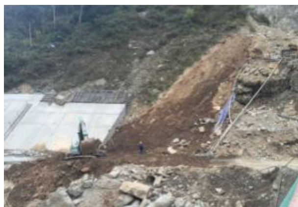
首部左岸上游混凝土护坡
