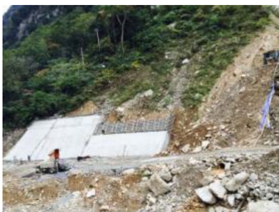
首部左岸上游混凝土护坡
