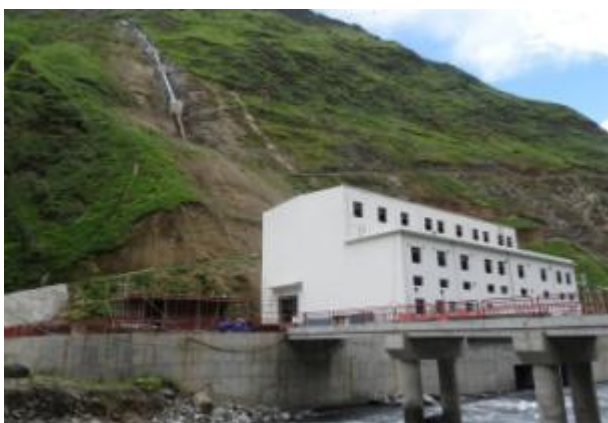
发电厂房外部施工形象图
