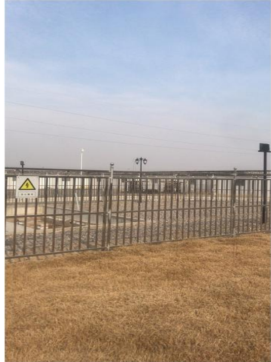
升压站内绿化
