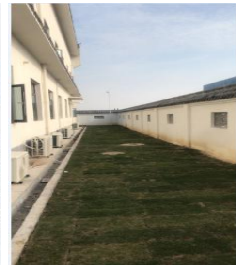
升压站内绿化
