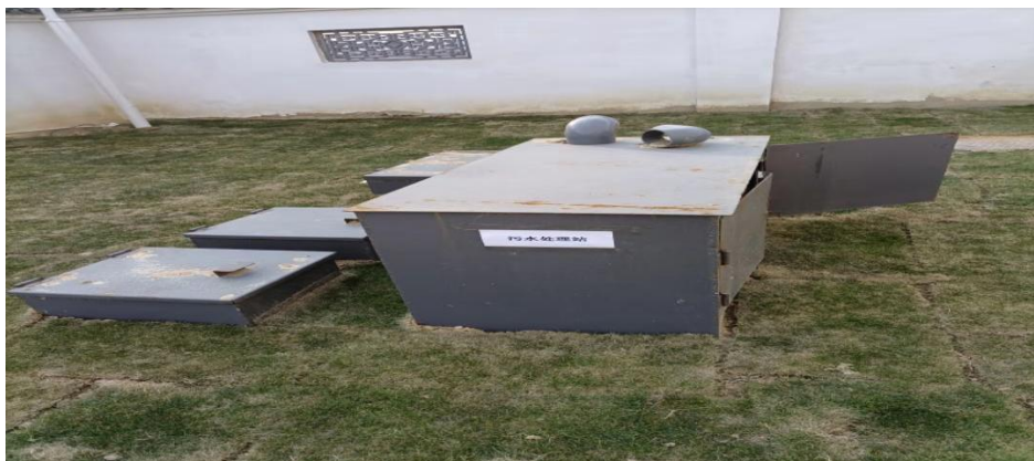
地埋式污水处理设施
