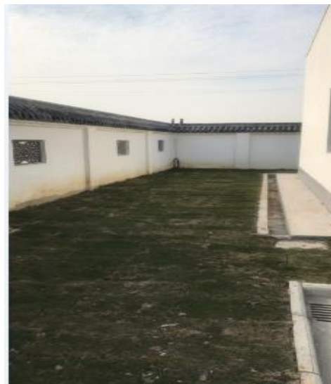
升压站内绿化
