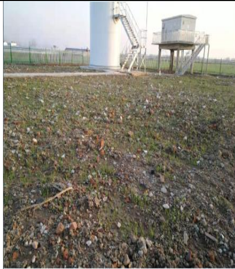
箱变基础扰动区植被恢复
