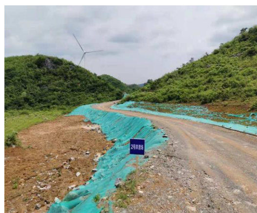
2 号弃渣场现状
