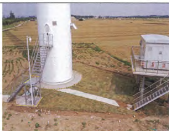
F14号风机永久占地植被恢复和临时占地复耕情况
