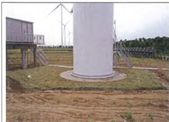
F13号风机永久占地植被恢复和临时占地复耕情况
