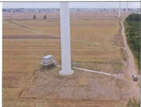
F10号风机永久占地植被恢复和临时占地复耕情况
