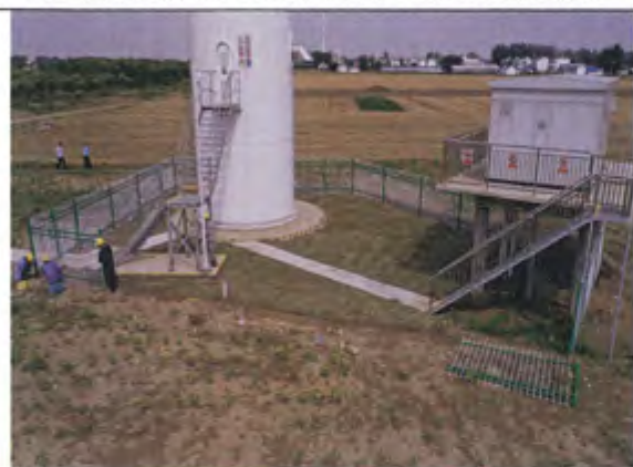
F15号风机永久占地植被恢复和临时占地复耕情况
