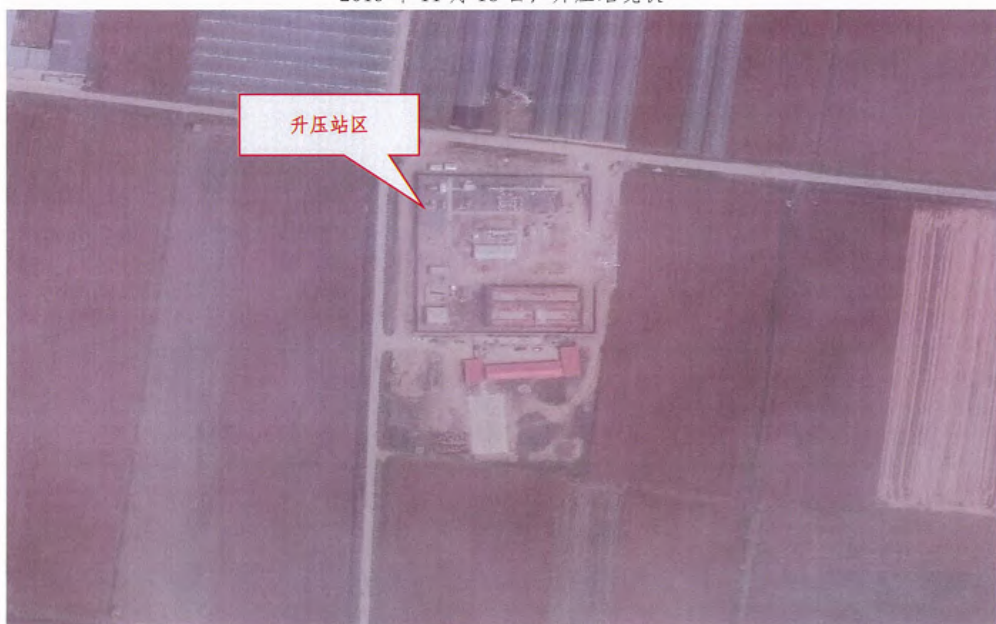
2020年5月28日，升压站现状
