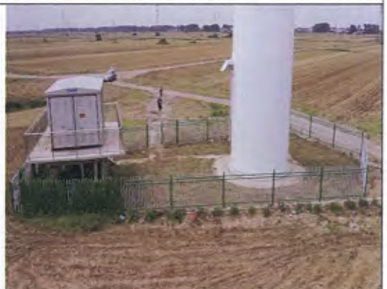
F2号风机永久占地植被恢复和临时占地复耕情况
