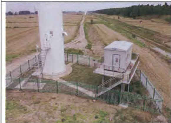
F3号风机永久占地植被恢复和临时占地复耕情况
