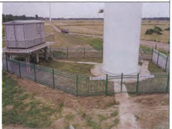
F4号风机永久占地植被恢复和临时占地复耕情况
