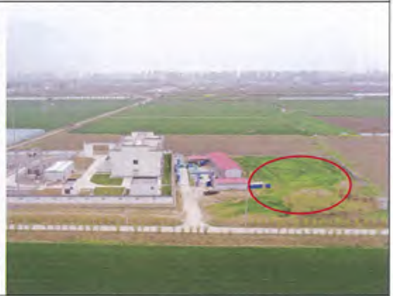
临时堆土场恢复现状
