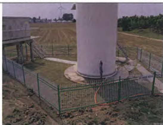
F16号风机永久占地植被恢复和临时占地复耕情况
