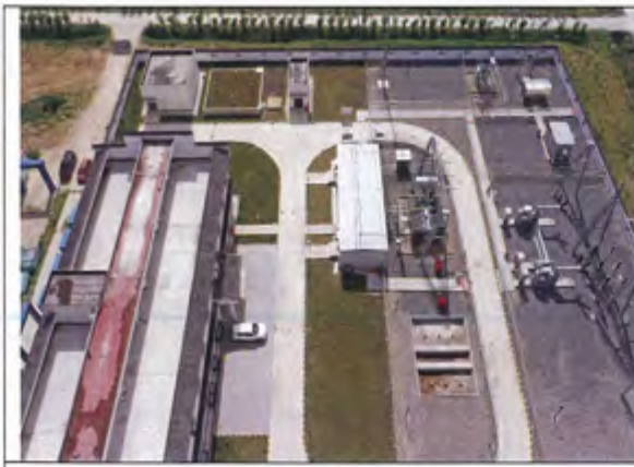
升压站区植被恢复情况
