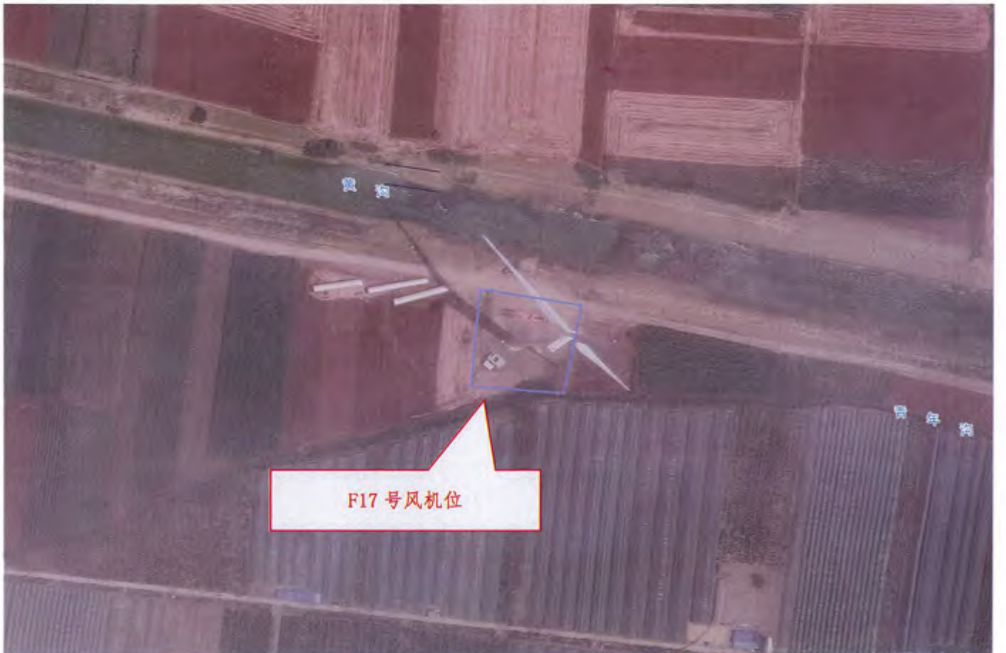
2020年5月28日，F17号风机吊装平台现状
