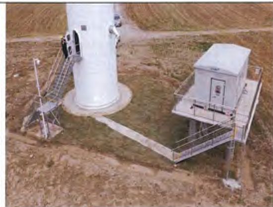
F6号风机永久占地植被恢复和临时占地复耕情况
