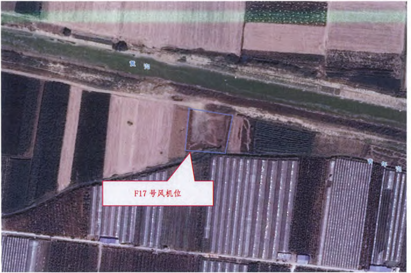
2019年11月18日，F17号风机吊装平台现状
