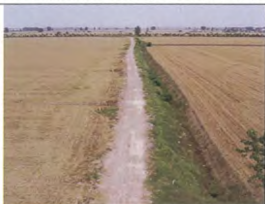
场内道路一侧排水沟措施
