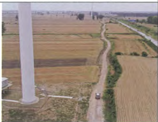
场内道路一侧排水沟措施
