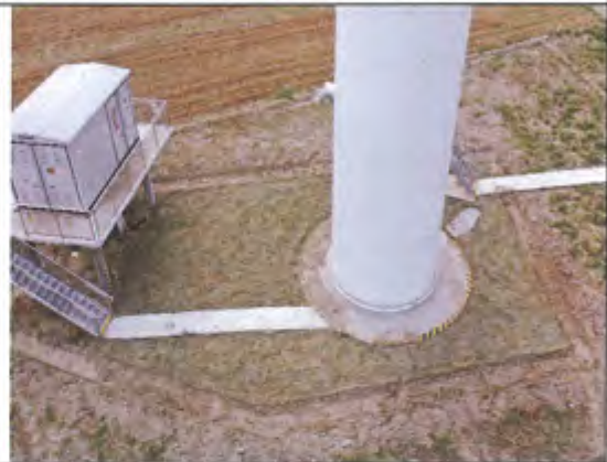
F8号风机永久占地植被恢复和临时占地复耕情况
