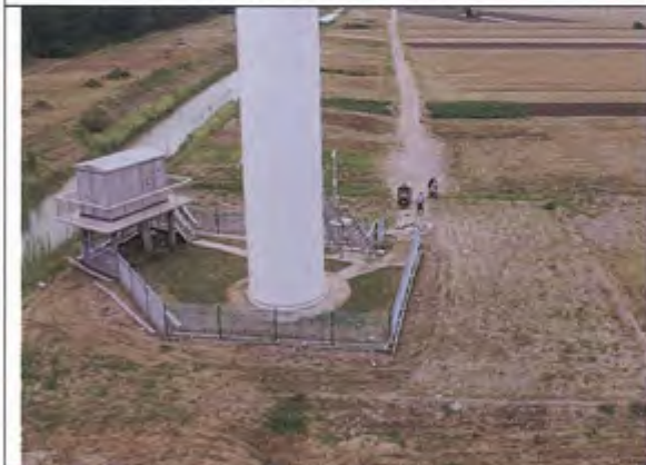
F1号风机永久占地植被恢复和临时占地复耕情况
