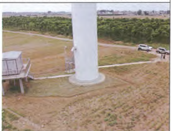
F12号风机永久占地植被恢复和临时占地复耕情况
