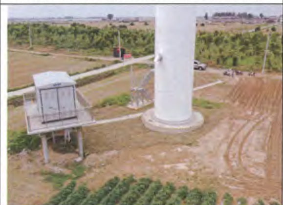
F11号风机永久占地植被恢复和临时占地复耕情况
