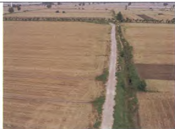
场内道路一侧排水沟措施
