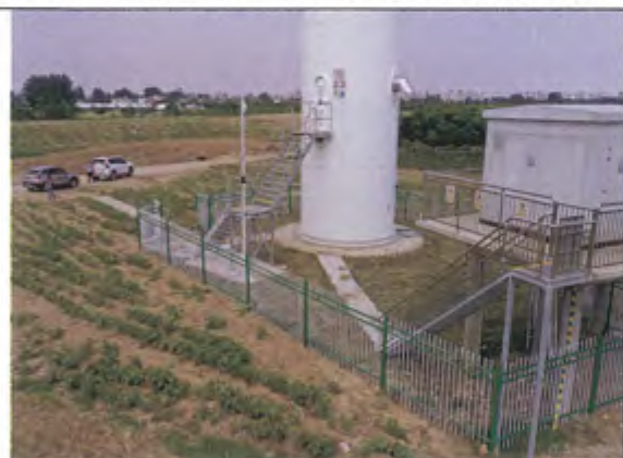
F17号风机永久占地植被恢复和临时占地复耕情况
