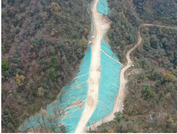
边坡防护及排水沟
