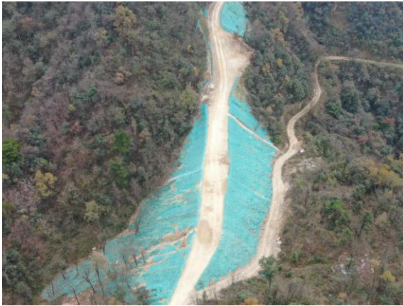
边坡防护及排水沟
